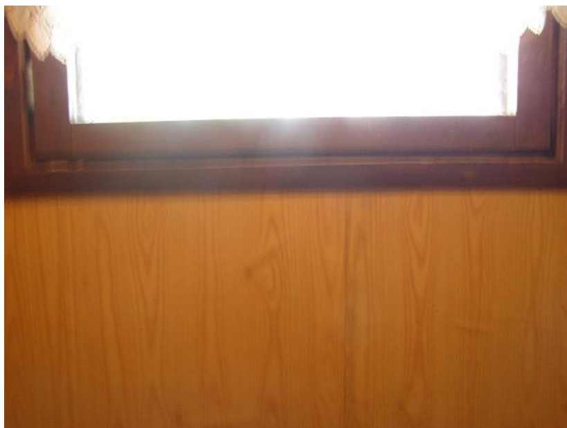
Kuva 32 vaihdettava ikkuna pesuhuoneessa (Hartikainen 2015.)
