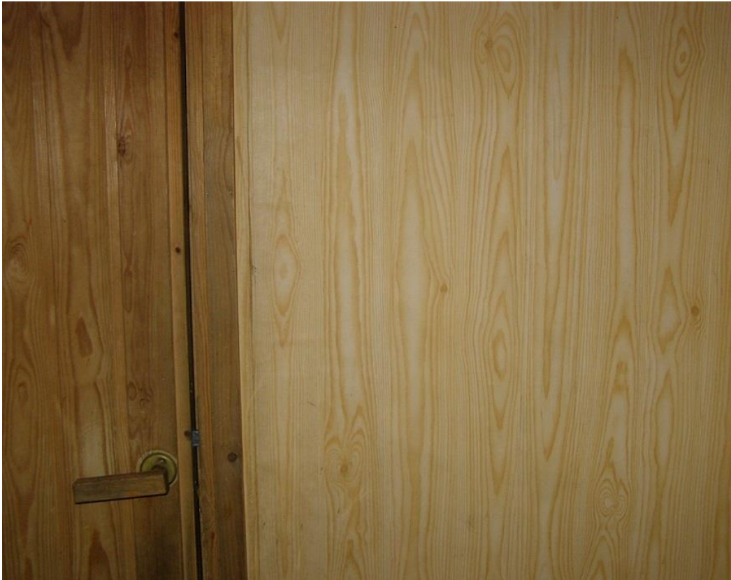
Kuva 20 Pesuhuoneen ja kodinhoitohuonen välinen seinä (Hartikainen 2015.)
