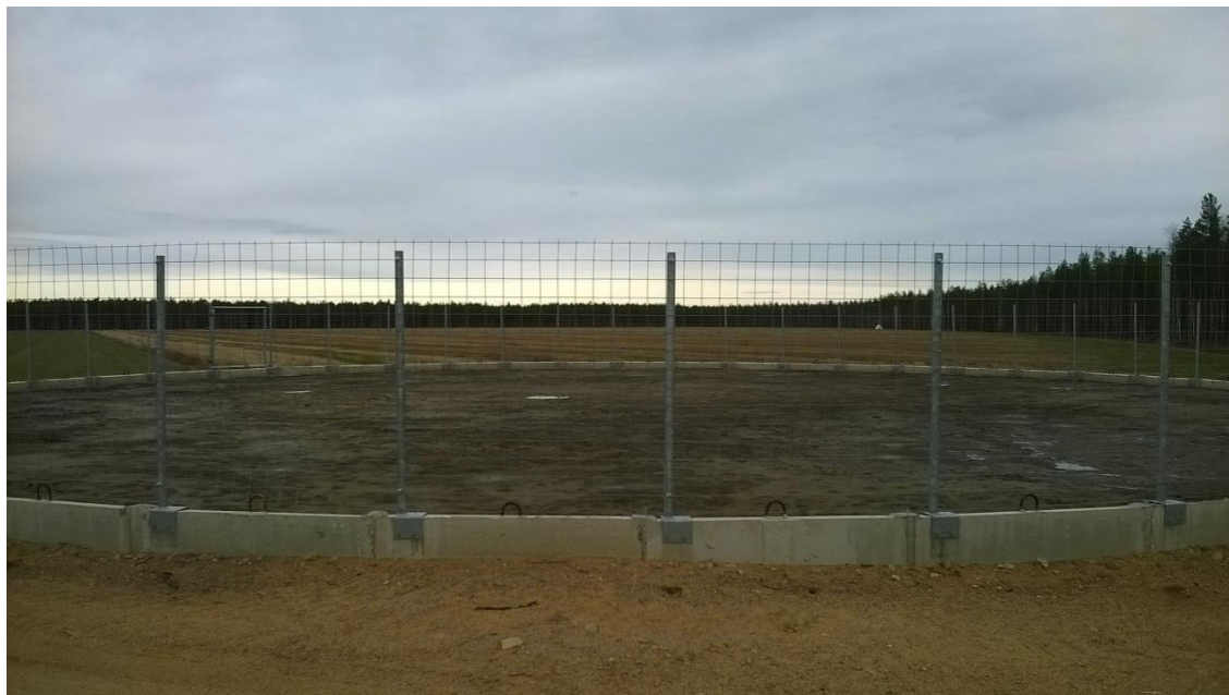
KUVA 5. Betonielementeistä rakennettu lietesäiliö (Huusko 2015)
