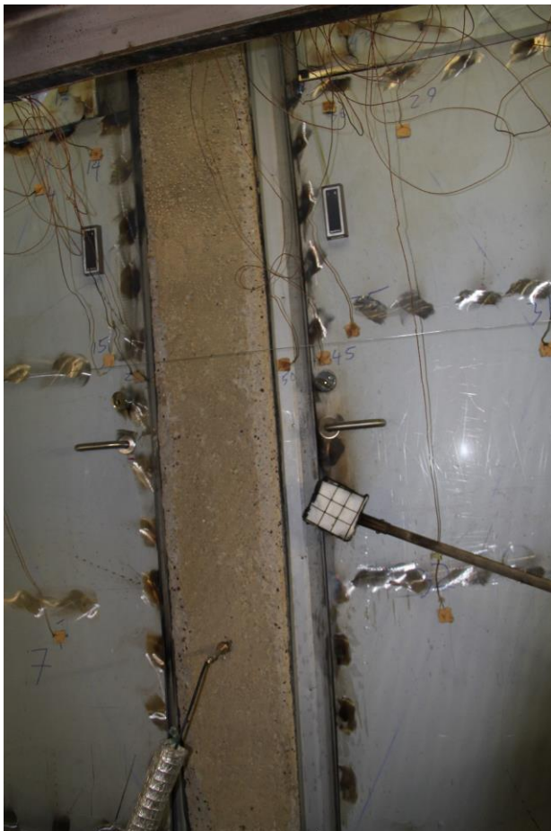
KUVA 10. Rakenteen tiiviyn mittaaminen puuvillavanalla
