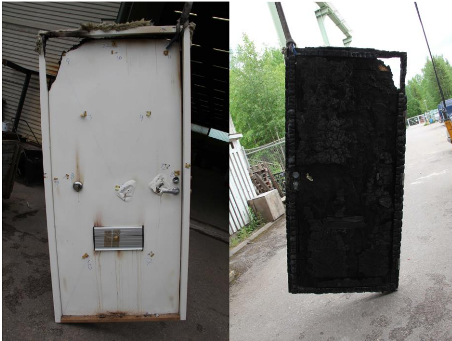
KUVA 14. Puinen palo-ovi palon vastakkaiselta puolelta ja palon puolelta
