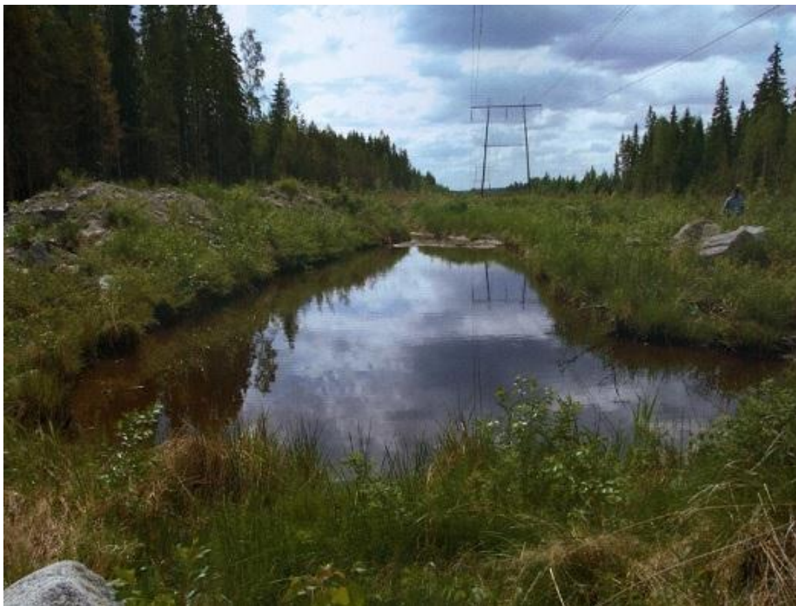
Bild 6. Sedimenteringsbassäng under högspänningsledning.
