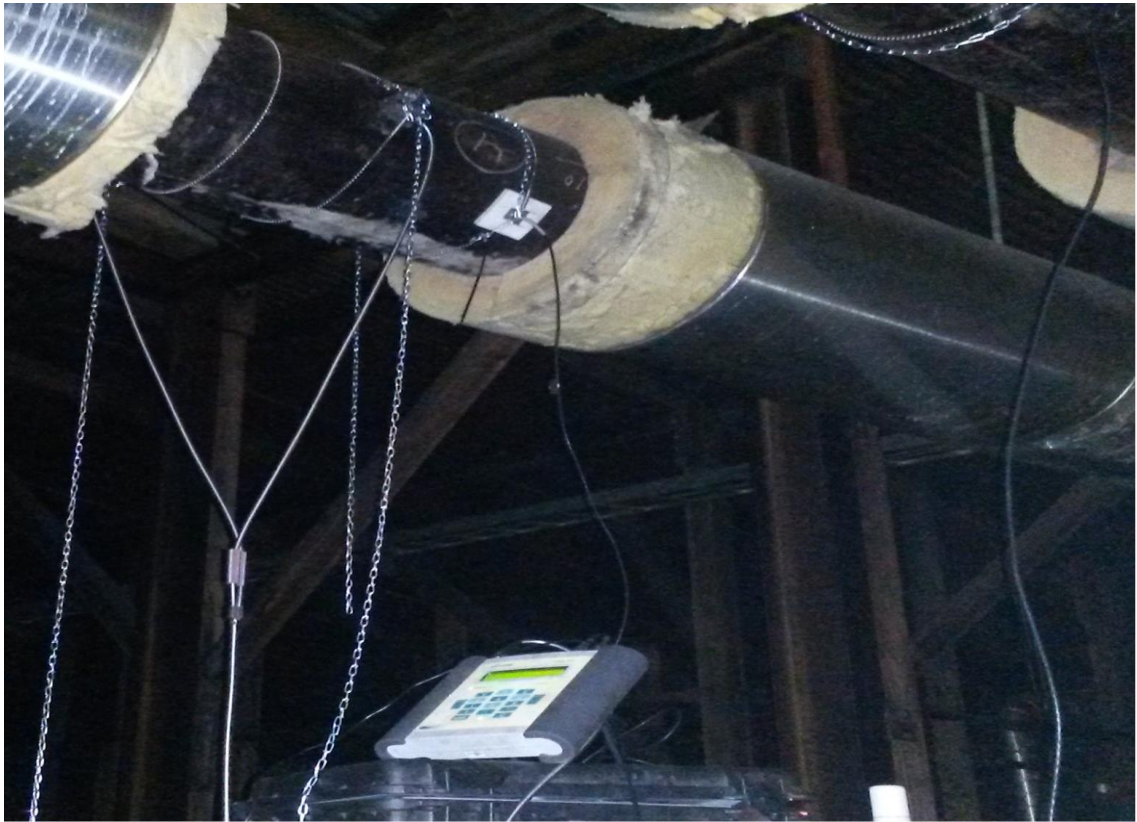
Kuva 10 Kuivaamon päälinjan mittaustilanne (Kuva: Petri Vanninen).
