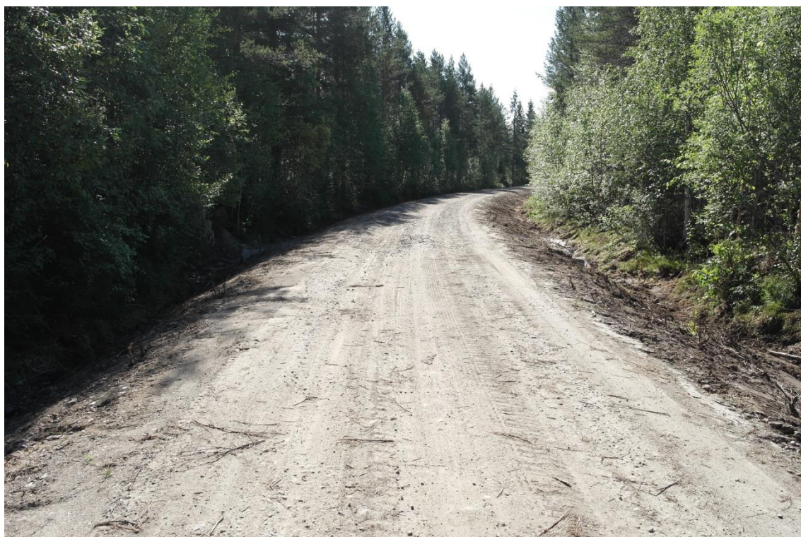
Kuva 1. Metsätie, josta sivuojat avattu. (Kuva: Atso Tarkkinen)
