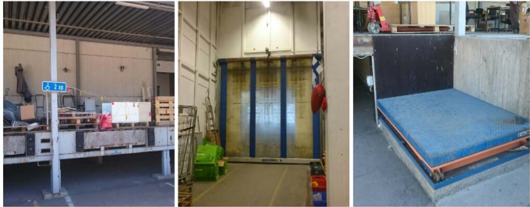
KUVA 14. Nihtisillan myymälän saapuvan tavarank lastauslaituri, lastauslaiturin nosto-ovi ja korkeussäädettävä nostopöytä. (Niskanen 2015a.)
