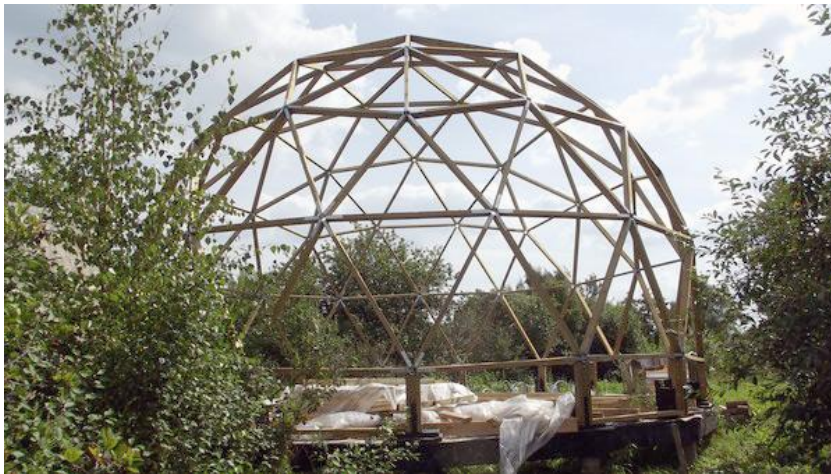
Kuva 3: Kupolitalon puurungon pystytys
