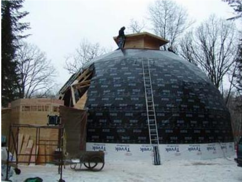
Kuva 13: Aluskerrin asennus ennen bitumikatetta
