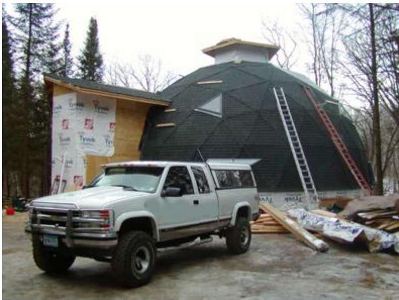
Kuva 14: Bitumikate valmis
