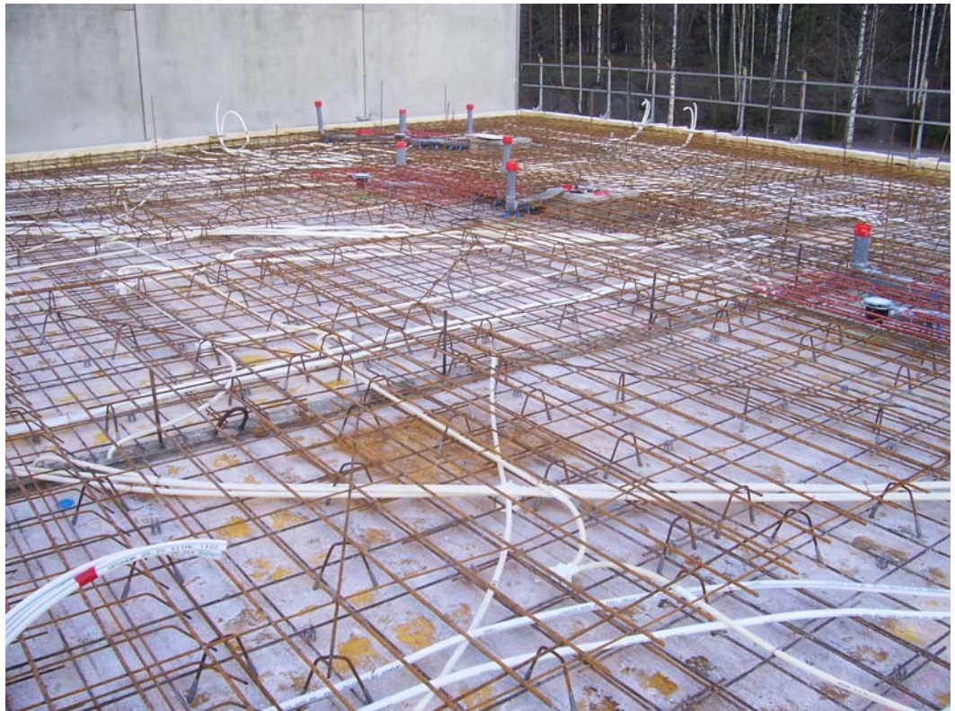
Kuva 6 Paikallavaluholvia raudoitettuna
