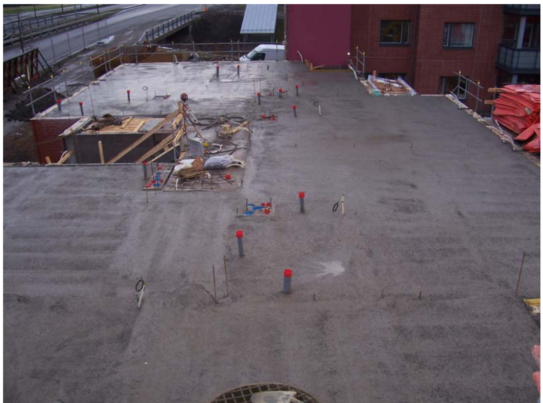
Kuva 7 Paikallavaluholvia valettuna
