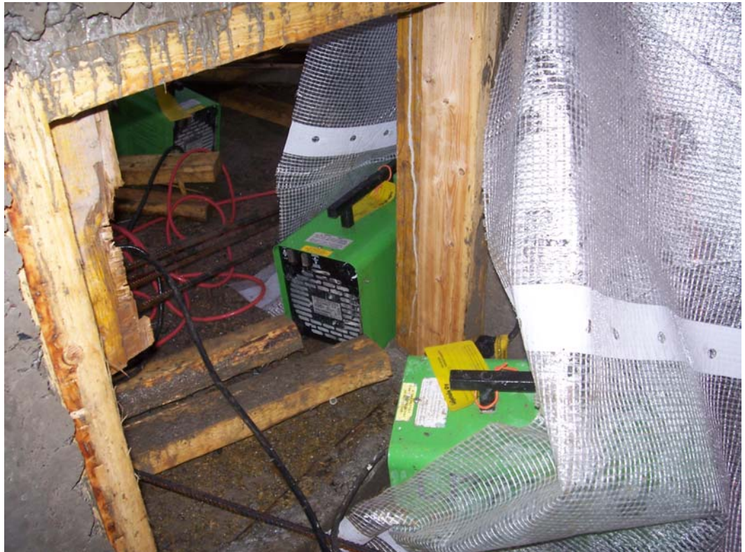
Kuva 3 Sokkelinostojen lämmitys puhaltimilla
