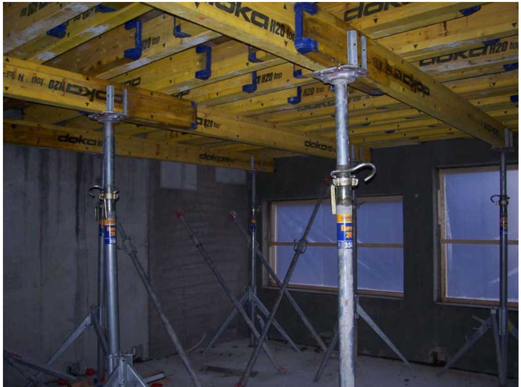
Kuva 8 Doka-muottikalustoa paikallavaluholvin alapuolella
