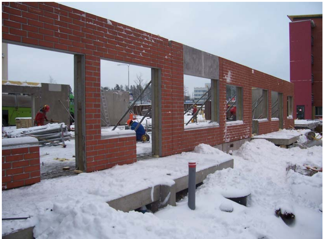
Kuva 1 Lumityöt tehtynä ja alusta sulatettuna ennen elementtiasennusta
