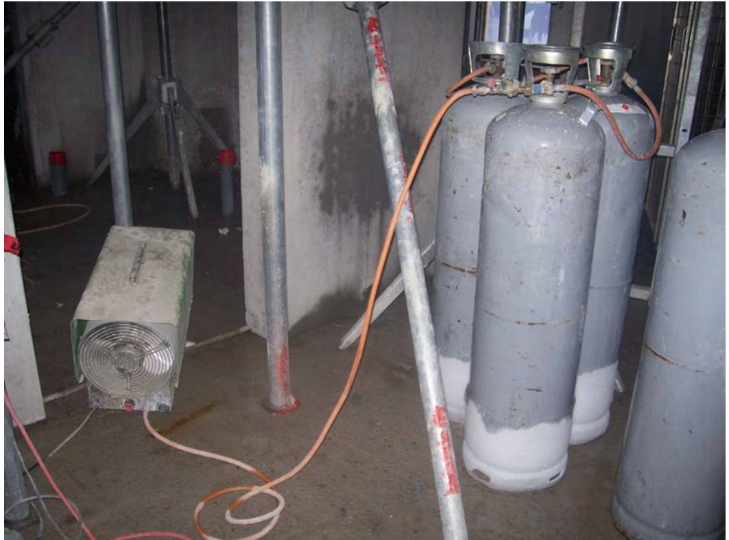
Kuva 4 Paikallavaluholvin kaasulämmitysjärjestelmä
