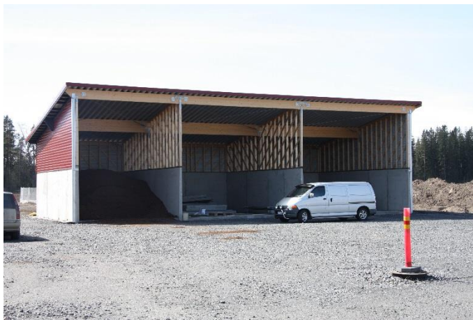
Kuva 47. Kuivikevarasto ja kuivalantala
