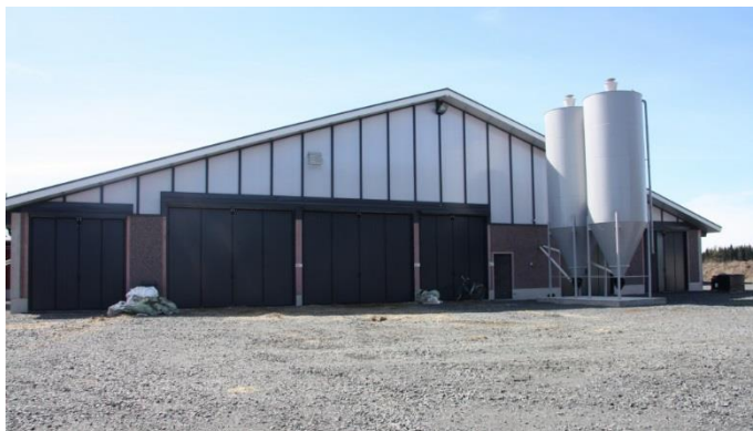
Kuva 45. Kaksi pystysiiloa navetan päädyssä
