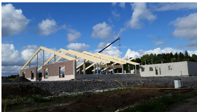
Kuva 8. Liimapuupalkit ja seinäelementit 21.8.2014
