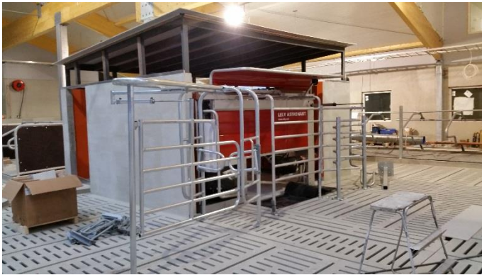
Kuva 13. Robotin asennus käynnissä 19.12.2014
