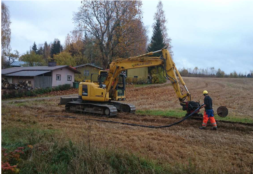
Kuva 5. Keskijännitekaapelin asentamista auraamalla.
