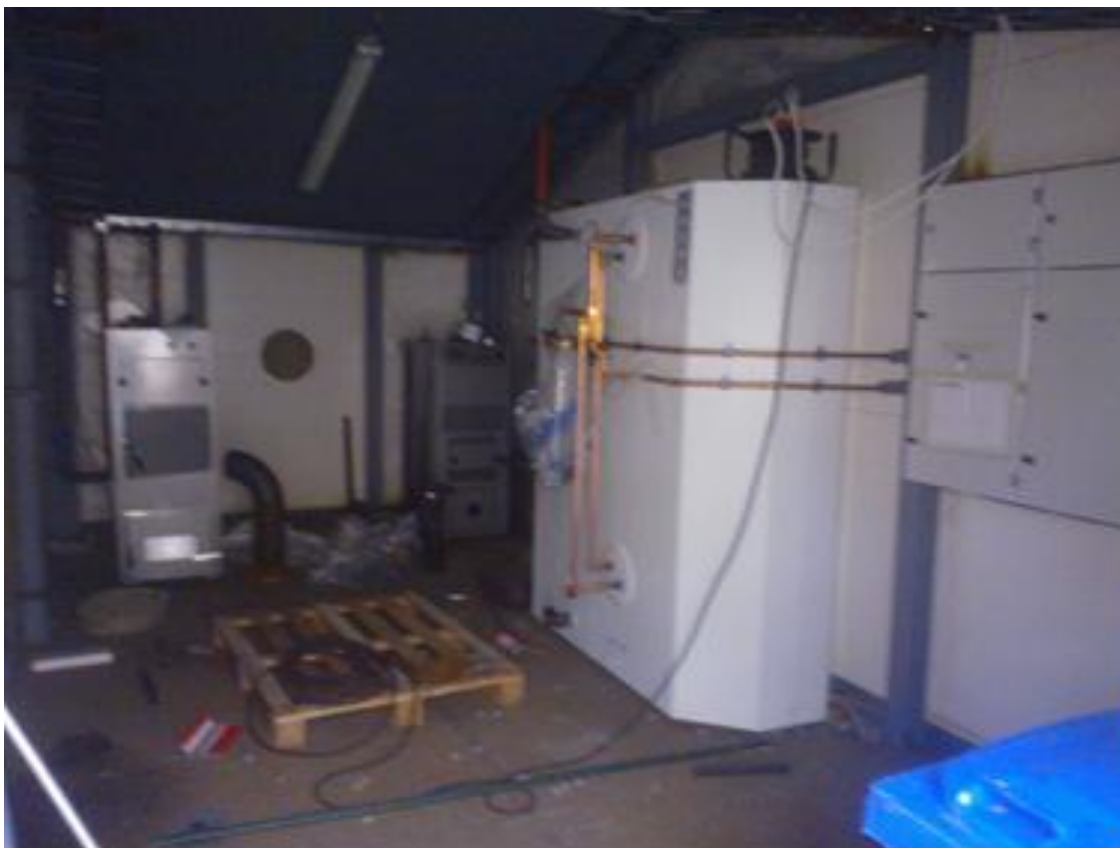
Kuva 7. LVI-laboratorio:n ensimmäisten laitteiden asennukset.
