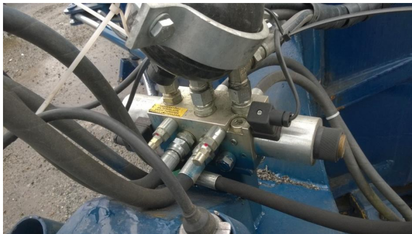
KUVA 20. Lisäsiipien sähköventtiili asennettuna. Valokuva Pekka Ryhänen 20.5.2015.
