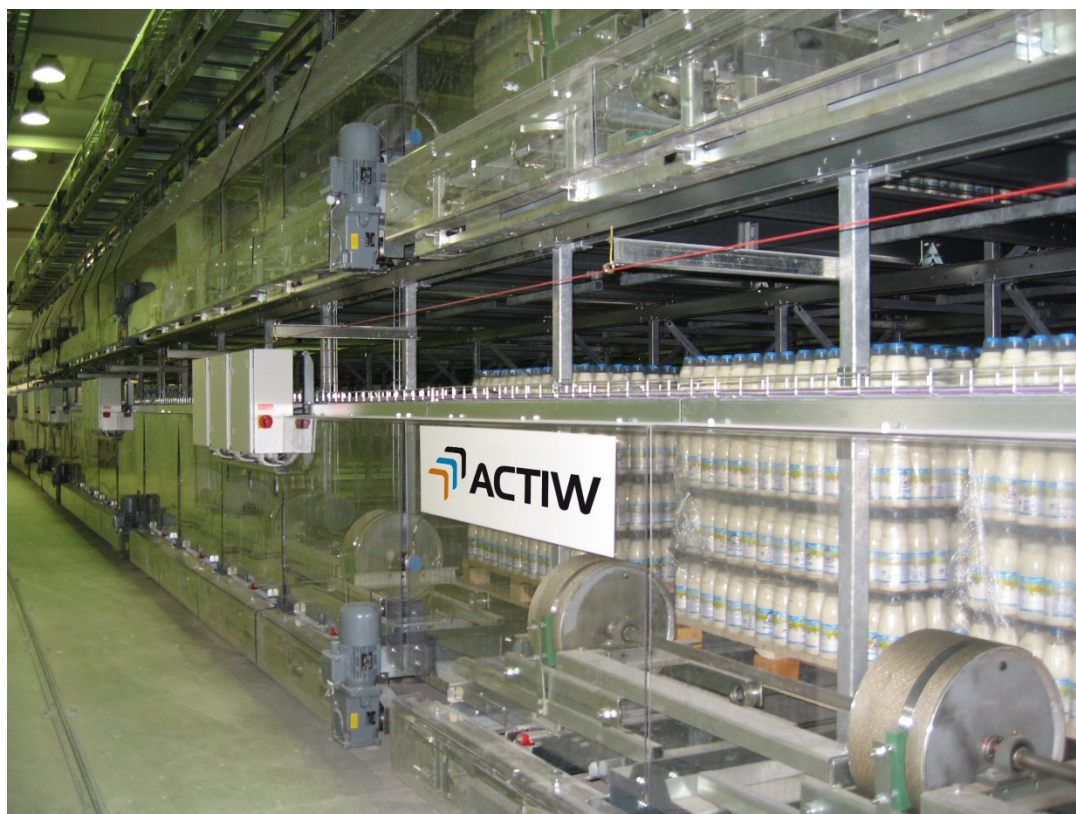
KUVA 4. Actiw-varastojärjestelmä (Actiw Oy.)
