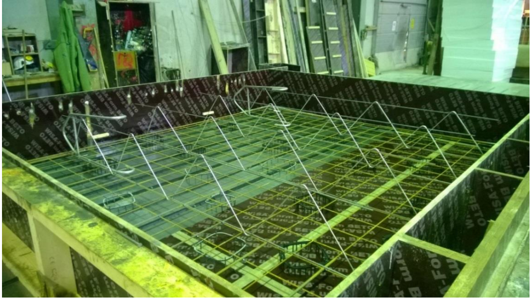
Kuva 3. Valmis muotti sekä ulkokuoren raudoitus.
