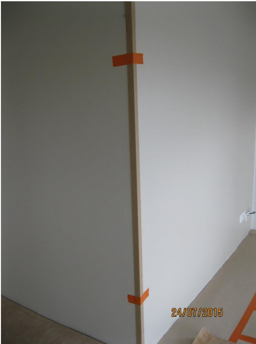
KUVA 22. Pahvikulma maalattujen seinien kulmien suojana
