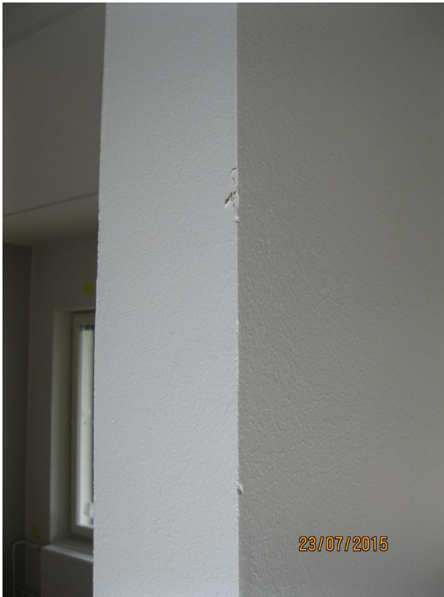
KUVA 21. Kolhuja valmiissa maalipinnassa
