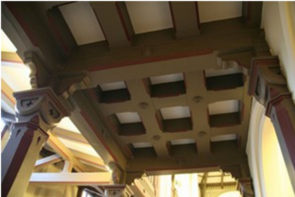
Kuva 25: Kattorakenteet parven alla 2014.
