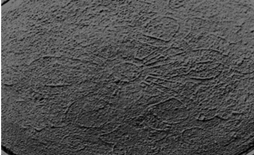
Kuva 15:Kirkkosalin spandrilli sivuvalossa. Kuvaa korostettu kuvankäsittelyohjelmalla.
