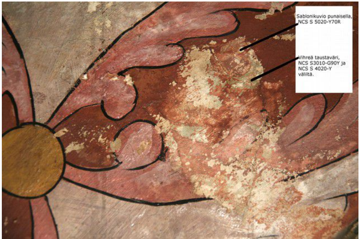
Kuva 12: Koristemaalauksen osa näkyvissä taaimmaisessa spandrillissa.
