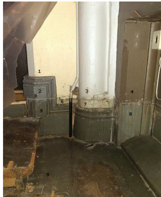
Kuva 20: Korjaustöiden yhteydessä esiin tullut pilarin alaosa.
