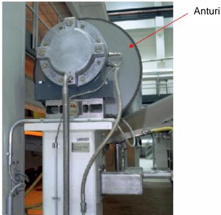
Kuva 2. Esimerkki kiihtyvyyssanturin asennuksesta
