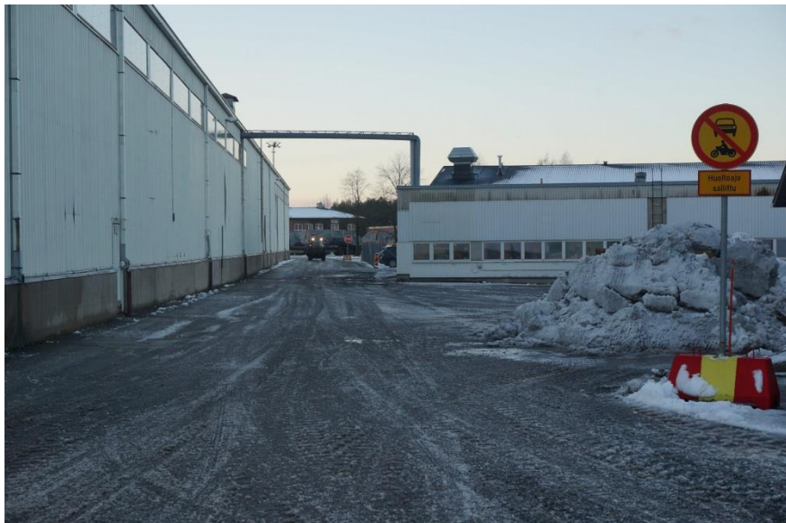
Kuva 16. S-rakennuksen ja maalaamon väli pohjoisesta etelään katsottuna
