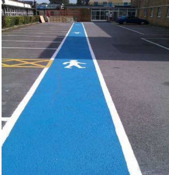
Kuva 23. Liukastumisen estävä jalankulkuväylän pinnoite (Freeindex.co.uk n.d)
