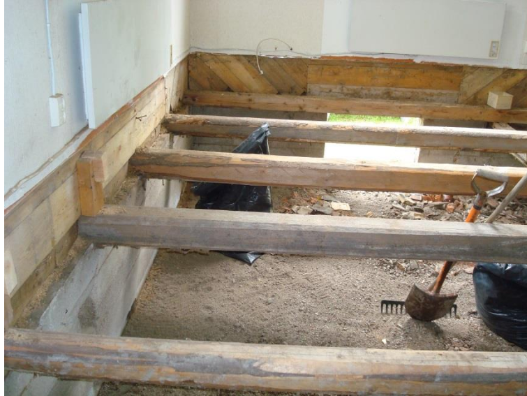
Kuva 12: Vanha alapohja on purettu. Taustalla on vanha poistettu käyntiluukku.
