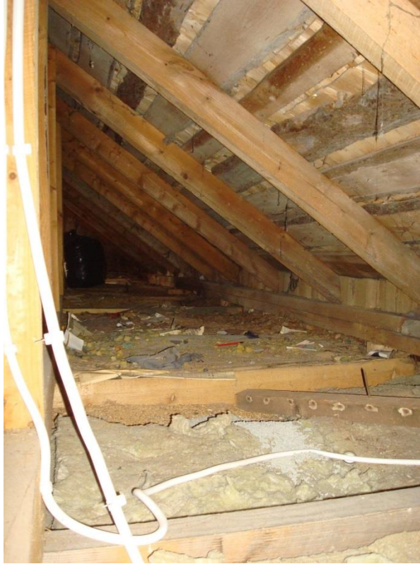
Kuva 8: Ullakkotiloissa ei havaittavia kosteusvaurioita puutteellisesta ilmanvaihdosta huolimatta.
