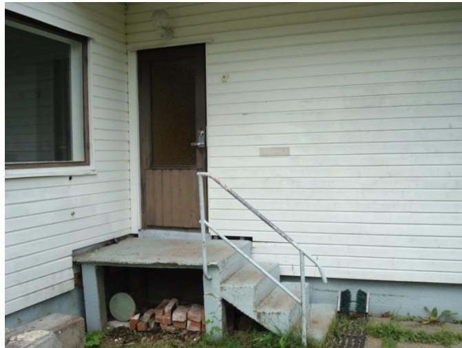
Kuva 6: Etuoven portaat poistetaan, ja ovi siirretään toiselle puolelle taloa.
