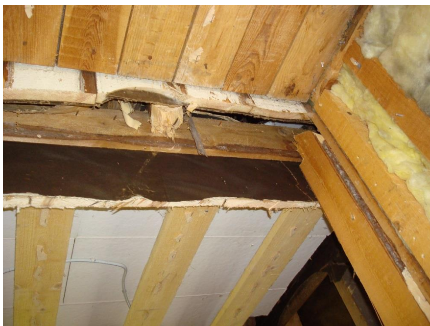
Kuva 18: Uuden ja vanhan puolen liittymäkohta seinän sisällä
