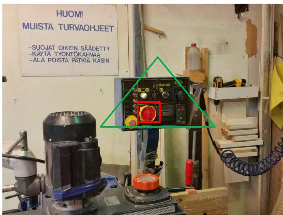
kuva 1. Hallintalaitteet ja lukittava päävirtakytin.(Ruotsalainen 2015)
