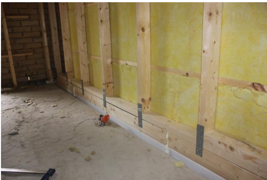
Kuva 4. Havainnekuva asennetuista valesokkelipalkeista korjauskohteesta.
