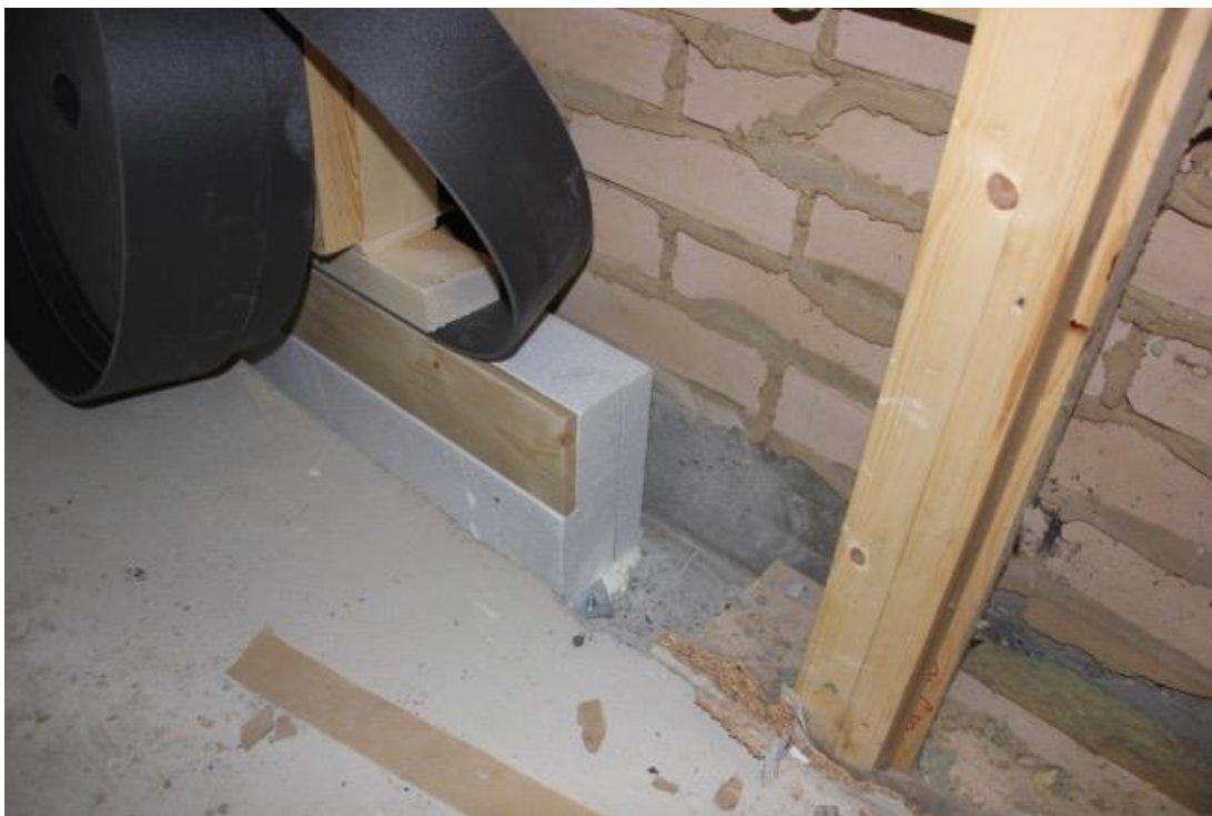
Kuva 3. Solumuovikaistan ja alaohjauspuun asennus korjauskohteessa.
