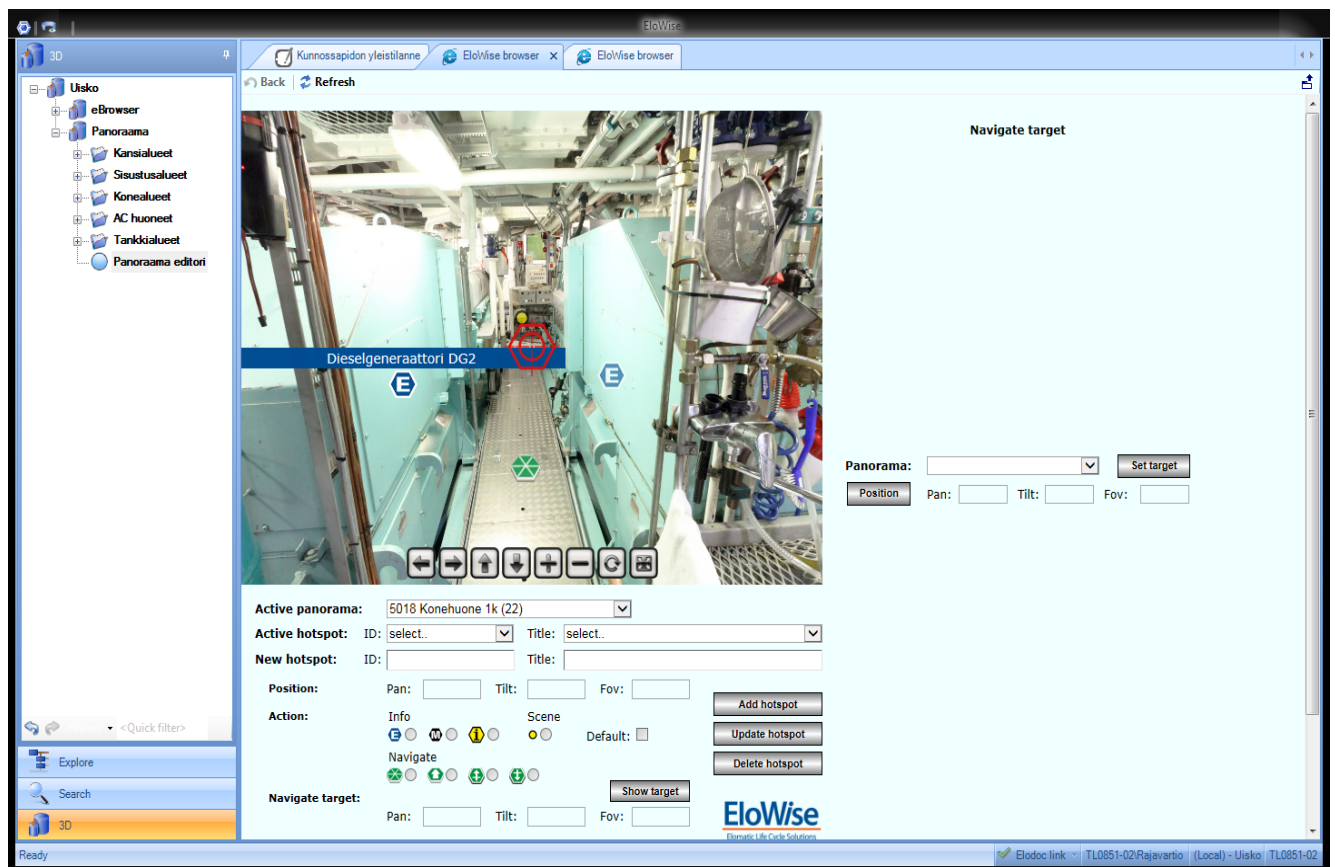
KUVA 17. Smart Point tietoruutu, dieselgeneraattori DG2
