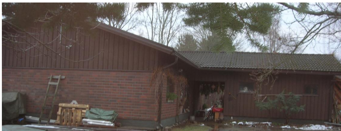
Kuva 3. Kuntotarkastuksen kohde pohjoisesta päin
