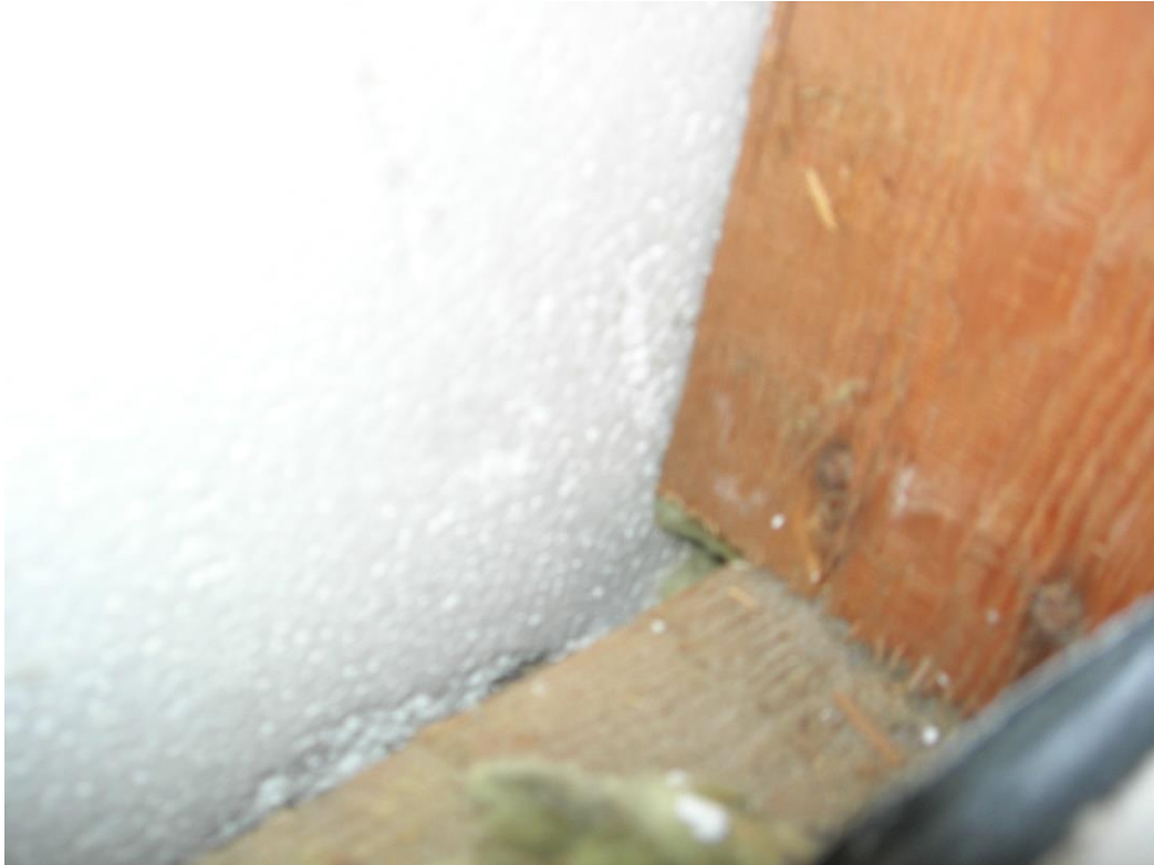
Kuva 7. Valesokkelirakenteen eriste, alajuoksu ja runkotolpan alapää, Mh, talon luoteiskulma
