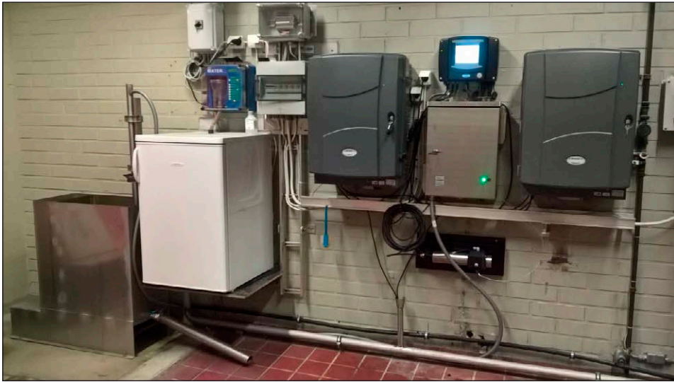
KUVA 2. Lähtevän veden ”mittauspatteri”. Hach&Lange Amtax, Nitratax ja Phosphax sc (kuva Jake Nylund)
