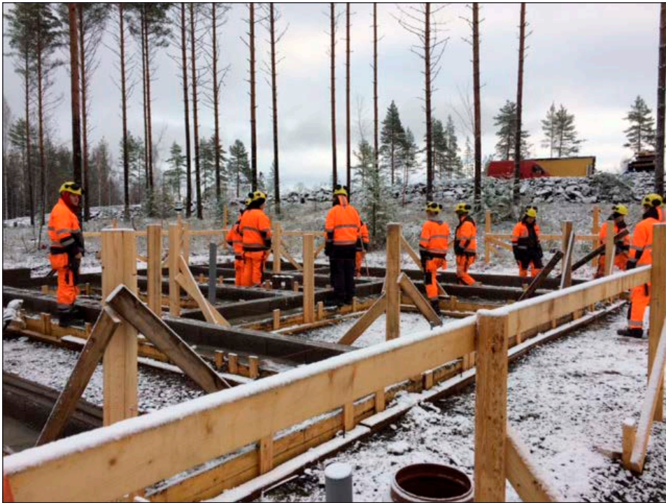
KUVA 6. Esedun opiskelijat tekemässä asuntomessualueelle nousevan konttitalon perustuksia (kuva Johanna Arola)
