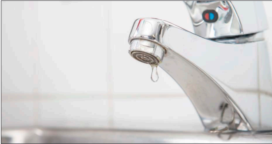
KUVA 1. Vuotovedet aiheuttavat ongelmia vesihuollossa (kuva Manu Eloaho)
