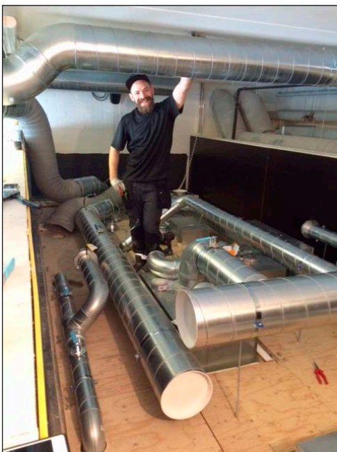
KUVA 3. Mamkin talotekniikan 3. vuoden opiskelija Kimmo Laine toteutti kahden luokkakaverinsa kanssa Testlab-oppimisympäristön IV-asennustyöt (kuva Johanna Arola)
