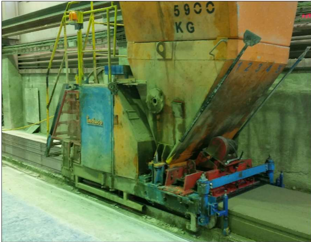
KUVA 2. Ontelopöydän valu käynnissä (Aaltokoski, 2016)
