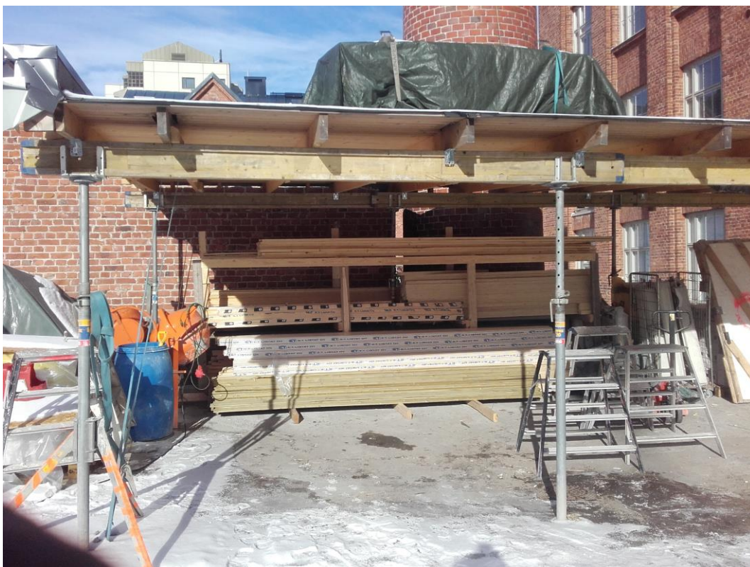
Kuva 8. Kosteudelle alttiit paneelit ja sahatavara on varastoitu säänsuojaan innovaatioisella tavalla. Kuva: Vesa Sainio 2017.
