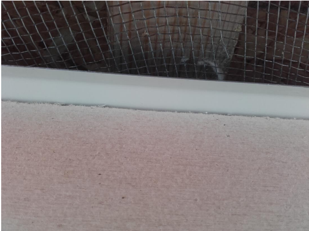
Kuva 5. Myrskypelti asennettuna rakennusvaiheessa ulkoseinärakenteen rappauslevypinnan taakse. Kuva: Vesa Sainio 2016.
