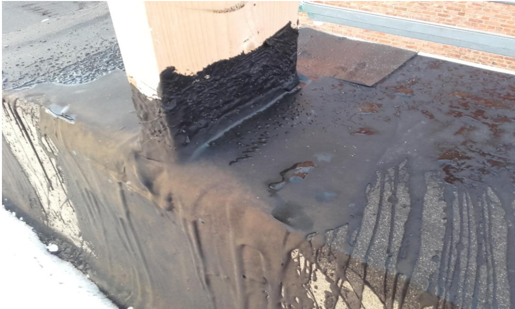
Kuva 4. Kuumabitumivalu puurakenteen ja vesikaton väliin. Kuva: Vesa Sainio 2016.
