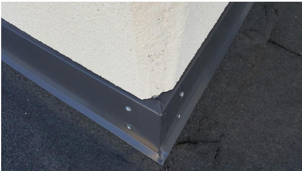
Kuva 12. Seinä-elementin saumaus ja työnlaadun tarkastaminen on tärkeää. Kuva: Christian Paajanen 2017.
