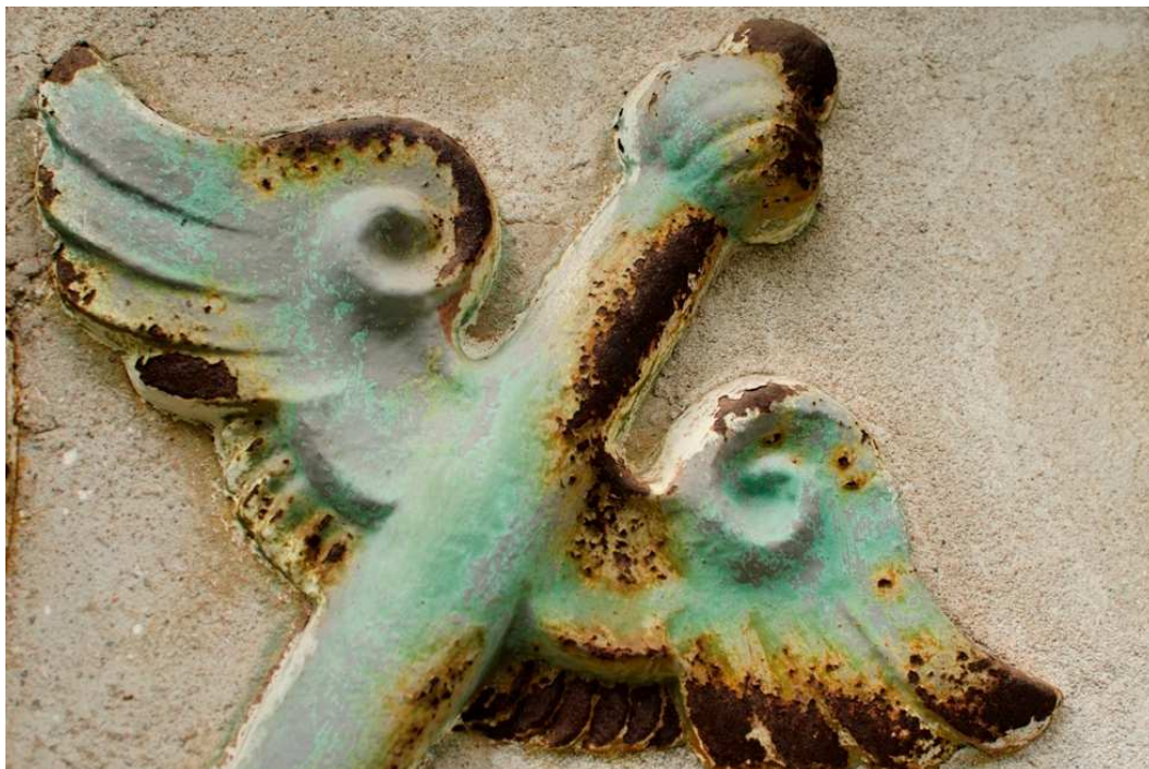
Kuva 8. Sauvan reunoilla näkyy jäämiä valkoisesta maalista. Vihertävä sävy on tyypillinen kuparipatinalle, kun taas tummanruskea aines on valuraudan korroosiotuotteita, ruostetta. Harmaa maali on todennäköisesti korroosionestomaalia. (Kuva: Heidi Kero.)
