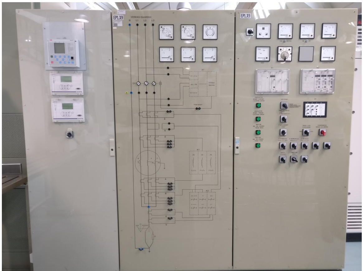
Kuva 1. Kuvassa vasemmalta oikealle - releovi, generaattoriovi ja ohjausovi
