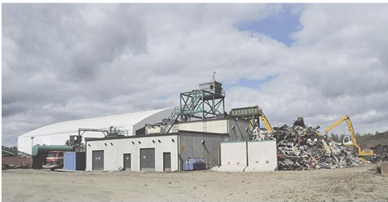
Kuva 1. Kajaanin Romu Oy:n murska-asema (Kajaanin Romu Oy, 2015)
