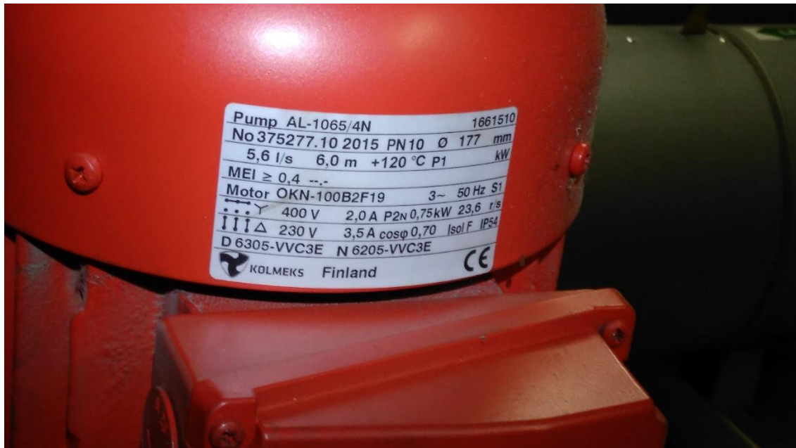
Kuva 9. TKE-laajennusosan pumpun LS03 P31 moottorin tyypikilpi
