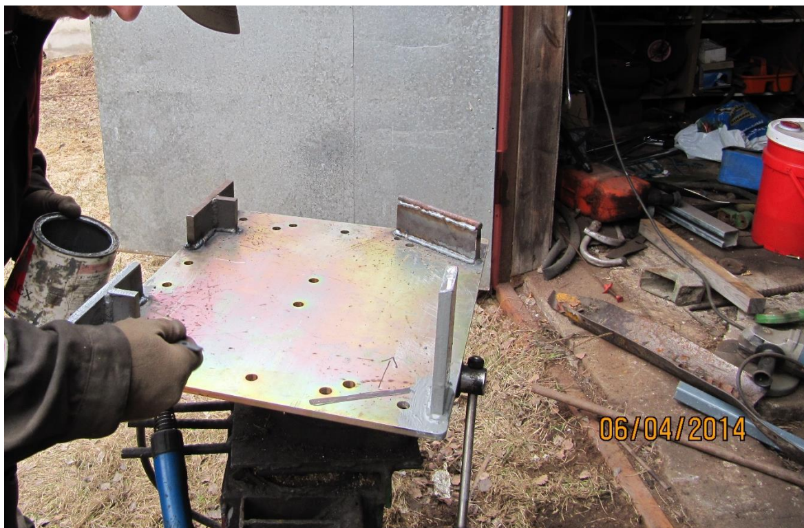
Kuva 7. Jalat hitsattuna kiinni kylvölaitteen asennuslevyyn.
