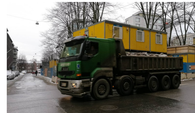
KUVA 12. Rekka kuljettaa kiveä pois työmaalta.
