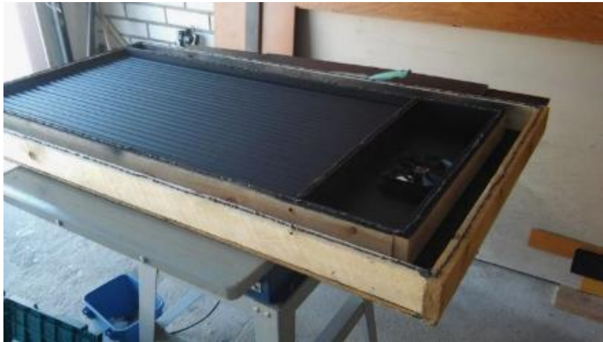
Kuva 19. Seinien saumoihin laitettiin tiivistemassaa.
