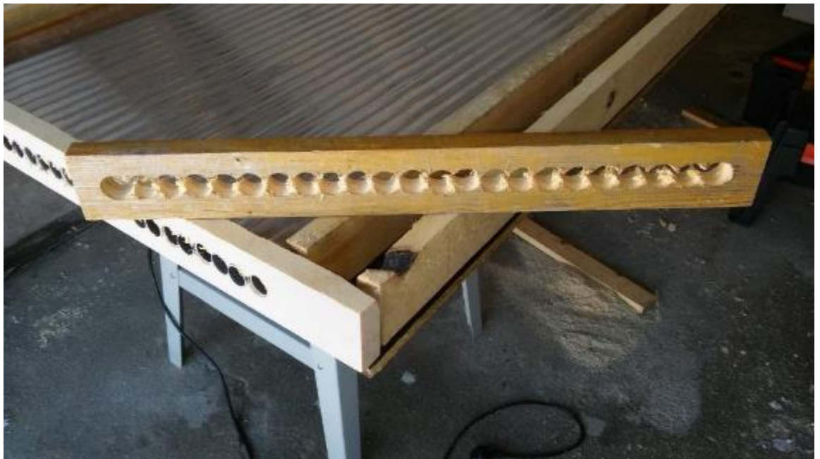
Kuva 14. Alumiiniputkia varten tehdyt reiät sisäseinässä.
