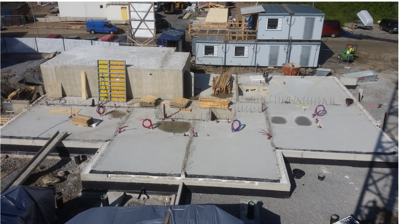
Kuva 1. Kerrostalon rungon työsuunnitelman lähtötilanne (Ovaskainen 2016-06-08)
