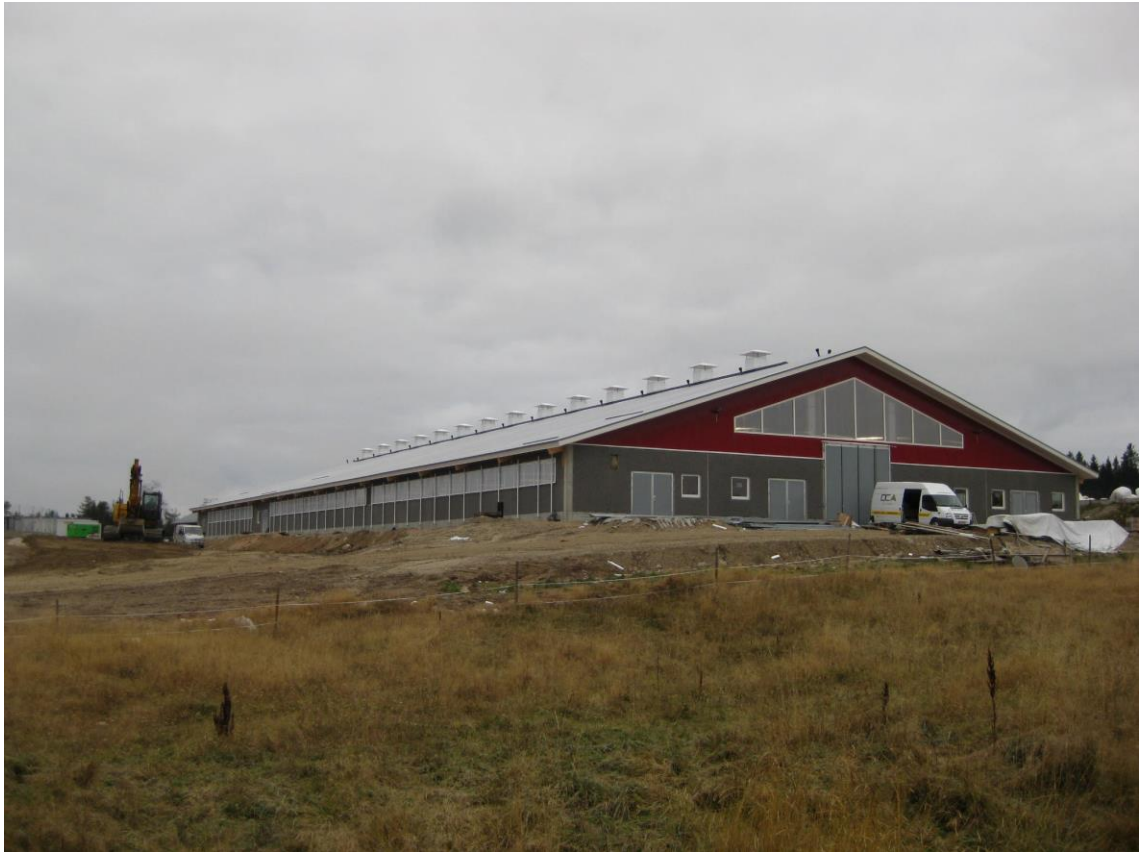
Kuva 1. Nykyaikainen karjarakennus (Lujabetoni Oy 2016).
