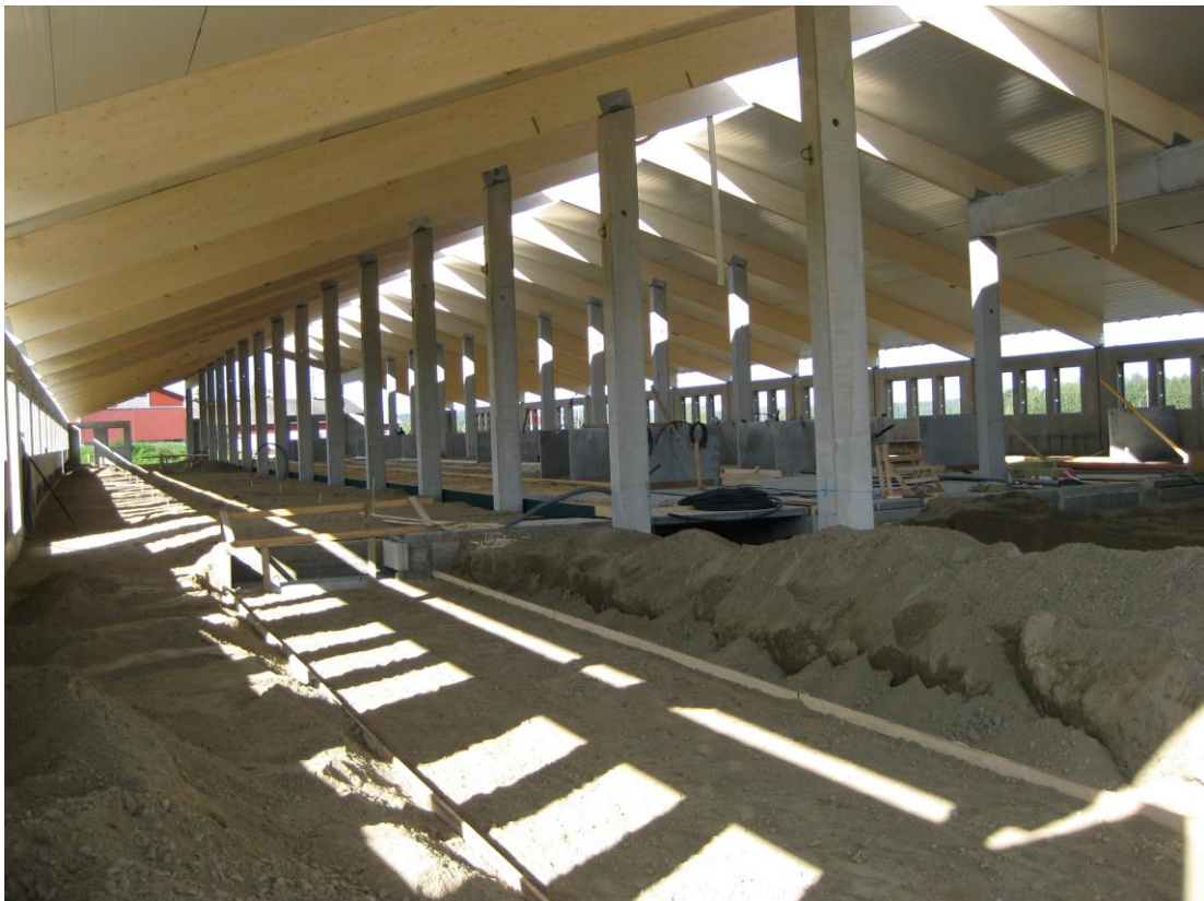
Kuva 2. Tyypillinen betonirunkoinen karjarakennus (Lujabetoni Oy 2010).
