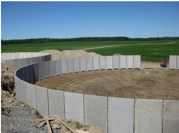
Kuva 10. Lietesäiliöelementit asennusvaiheessa (Lujabetoni Oy 2013).
