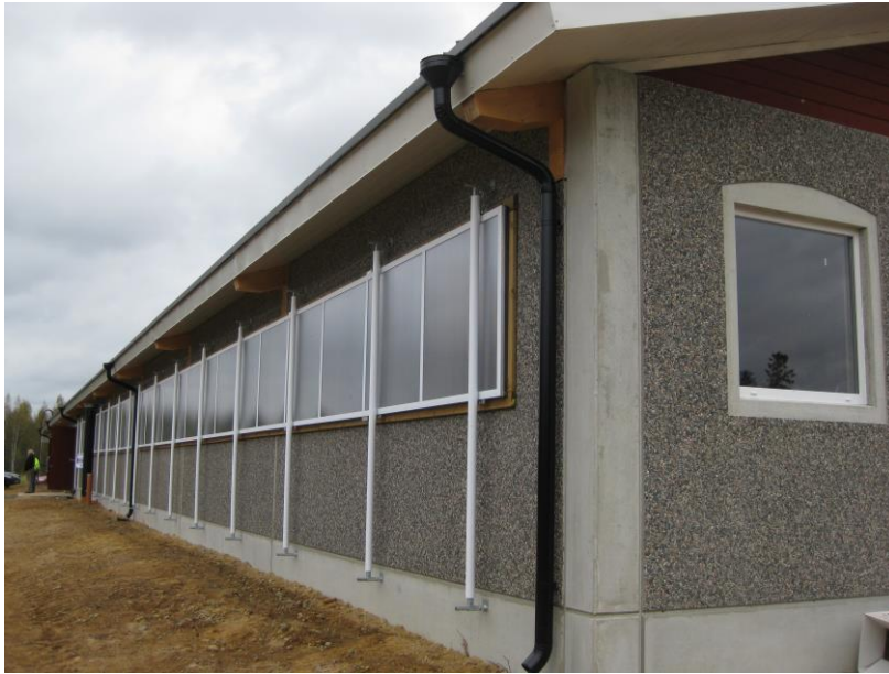
Kuva 3. Alas laskettavat kennolevyt ulkoseinällä (Lujabetoni Oy 2012).
