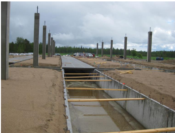
Kuva 7. Lietekanavaelementit ja ritiläpalkit asennusvaiheessa (Lujabetoni Oy 2017).
