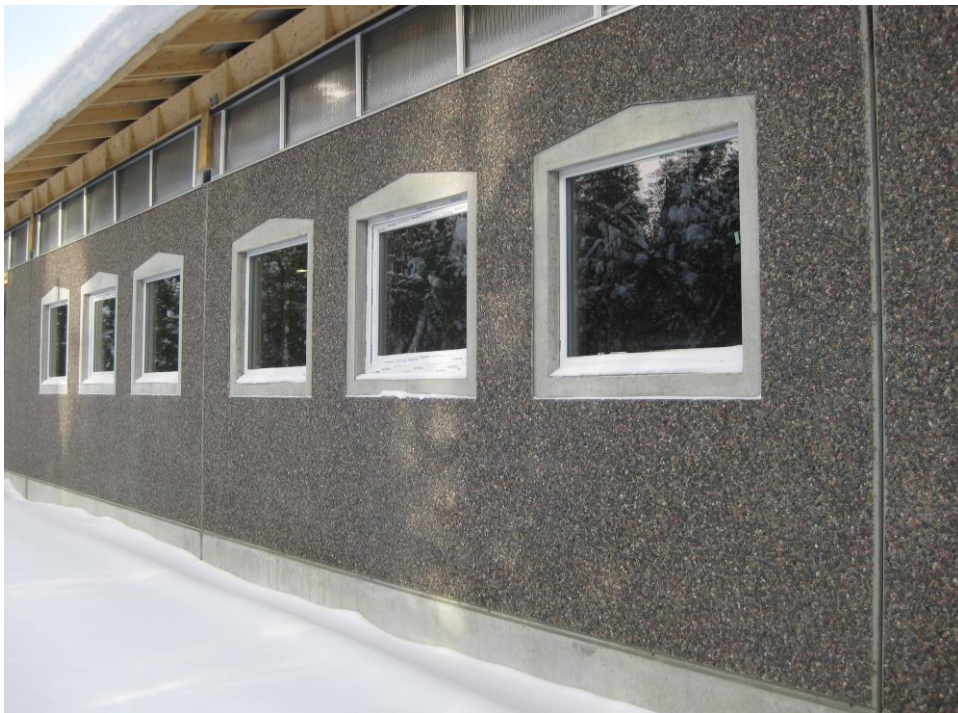
Kuva 9. Ulkoseinäelementti pesubetonipinnalla (Lujabetoni Oy 2010).
