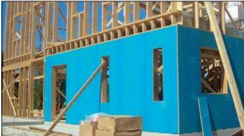
KUVA 13 Tuulensuojalevyn asennus (5, s. 1)
