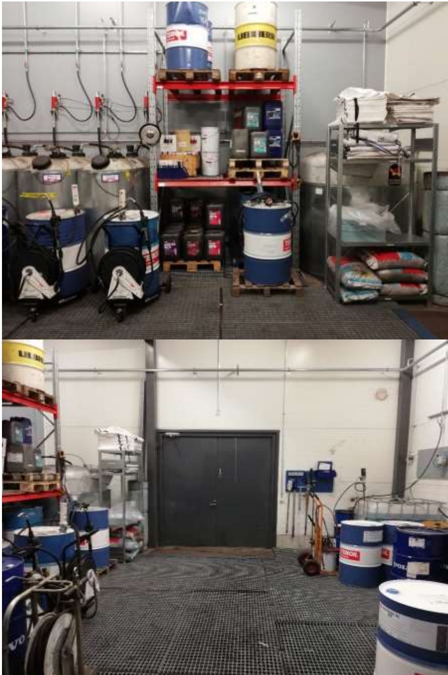
KUVA 6. Öljyvarastoon saatiin liikkumatilaa myös trukille
