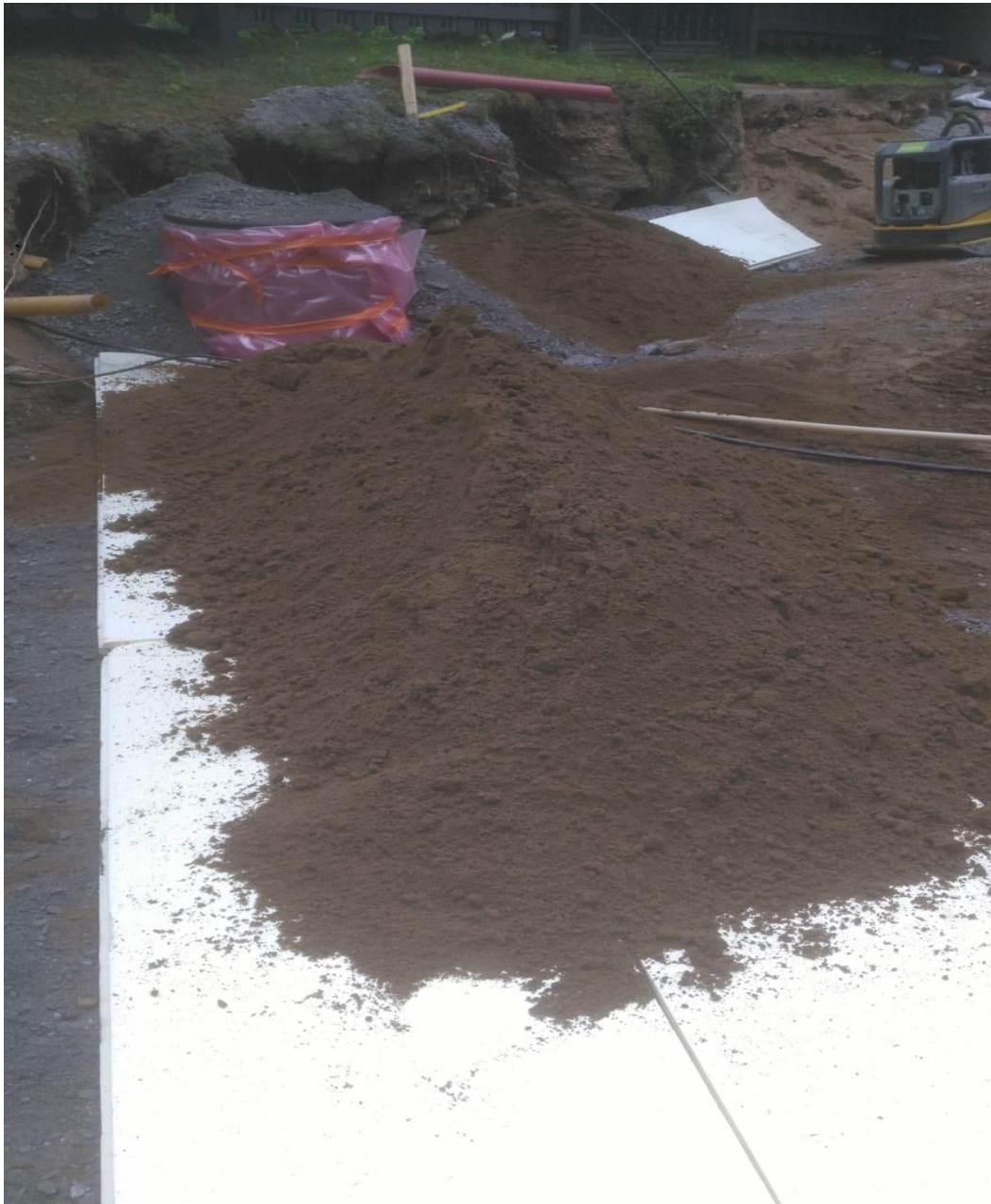
Kuva 12. Sadevesikaivojen putkivälin eristys.
