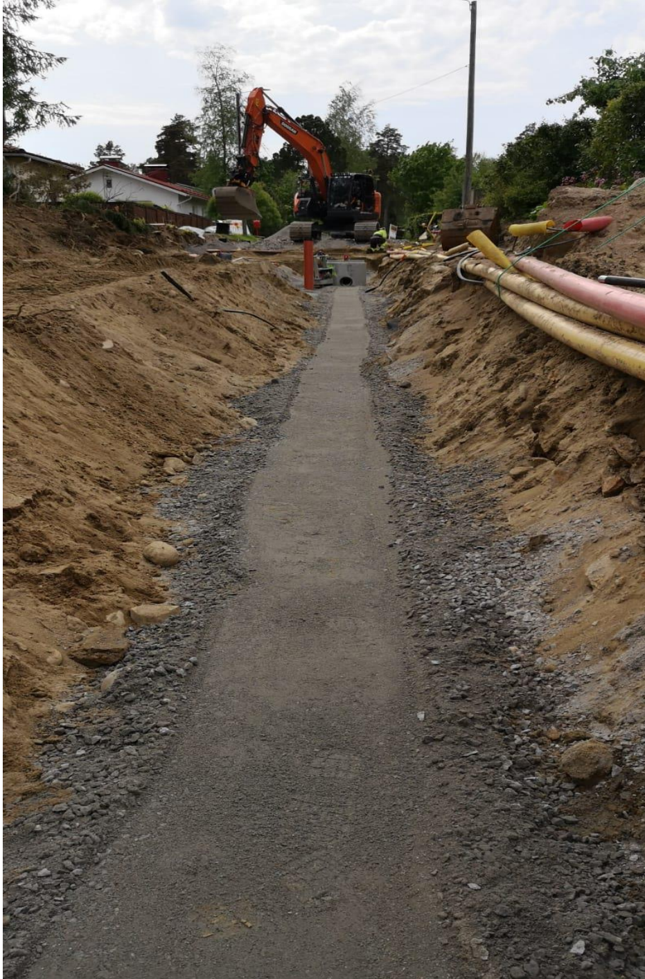
Kuva 1. Sadevesiputkelle valmis arina.
