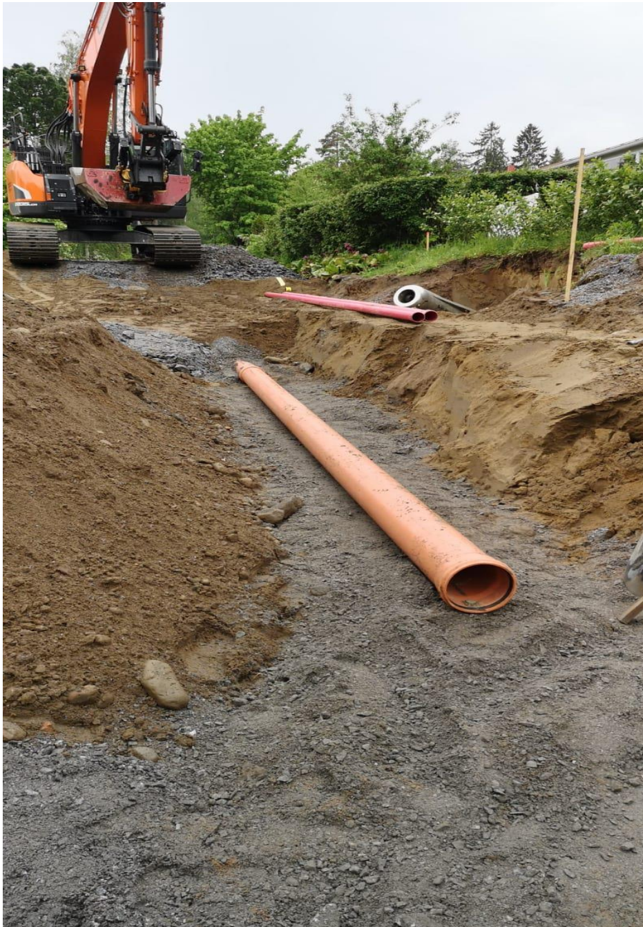
Kuva 9. Sadevesilinjan runkoputki rivitaloalueella, halkaisija 250 mm.
