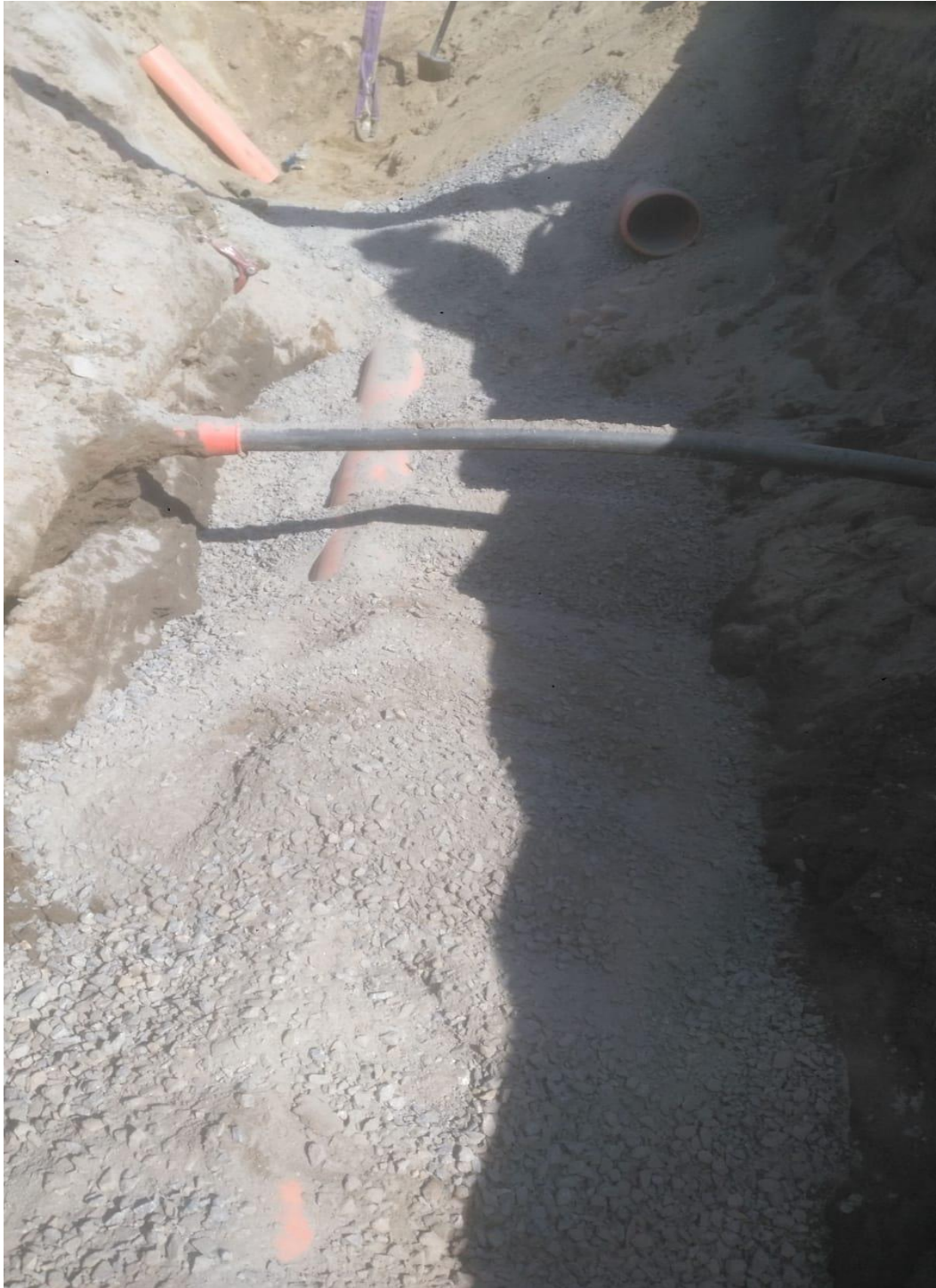
Kuva 3. Kuvassa olevan oikean putken päällä noin 40 cm suojatäyttöä, eli tässä tapauksessa 16 mm mursketta.
