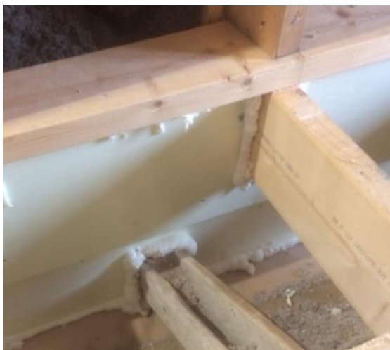
Kuva 21. Höyrynsulun tiiviyyden varmistus xps-levyllä ja tiivistysvaahdolla.
