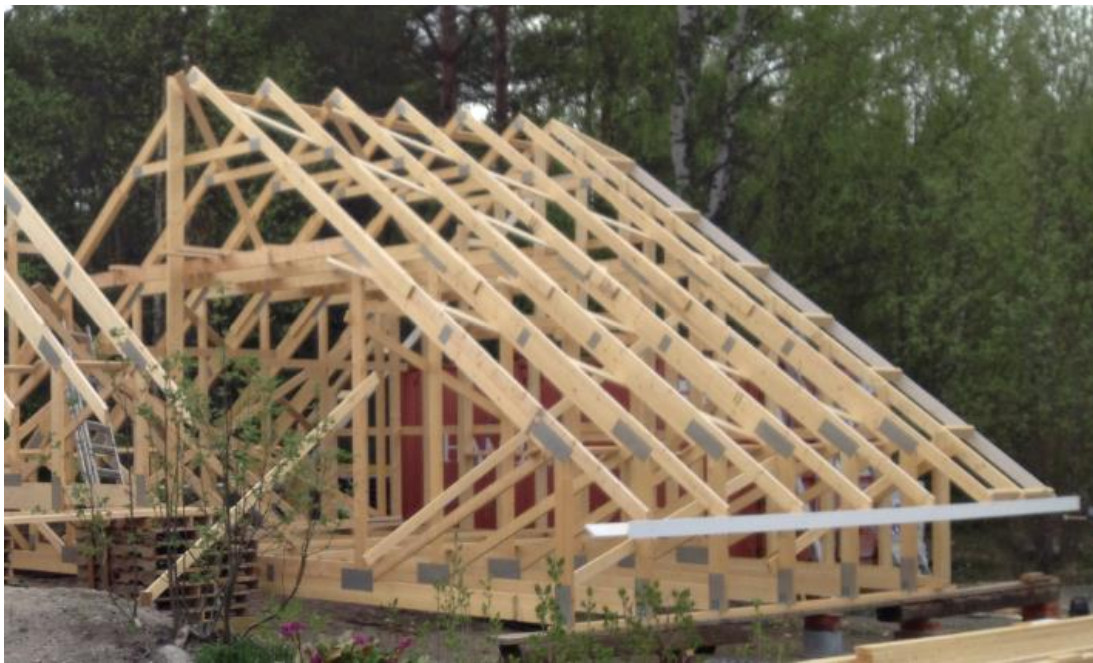
Kuva 9. Ristikot kasattu lohkoksi.
