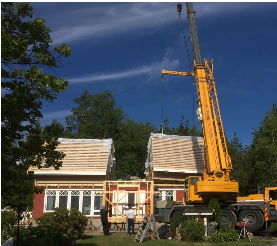
Kuva 12. Lohkojen nosto
