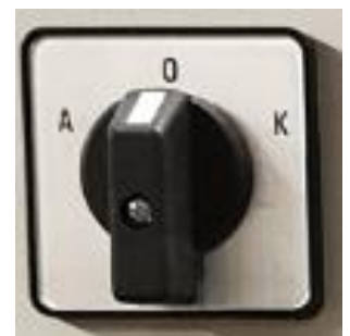
KUVA 2. Käyttötilan valintakytkin
