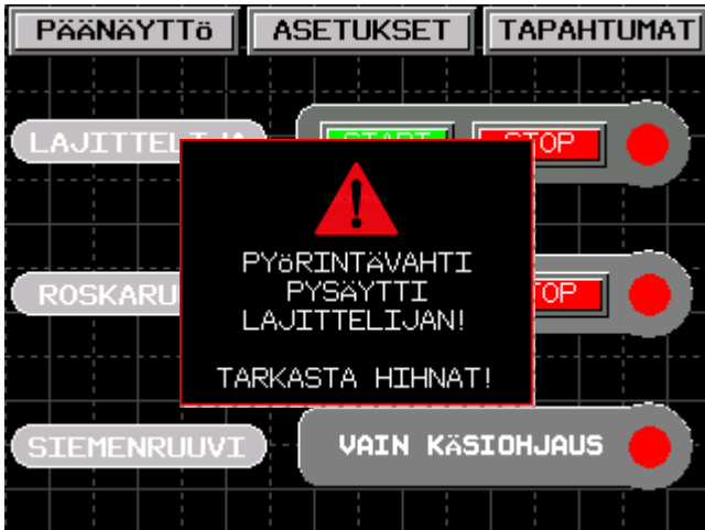
KUVA 21. Pyörinnänvartijan häiriön aiheuttama ilmoitus
