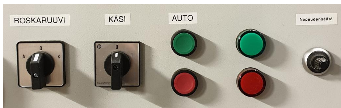
KUVA 5. Roskaruuvien ohjauskytkimet
