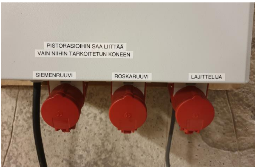
KUVA 10. Moottoreiden liittämiseen tarkoitetut 3-vaihepistorasiat
