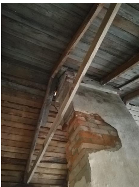
Kuva 30. Ullakon pohjoispään ikkunan puoleinen hormi.
