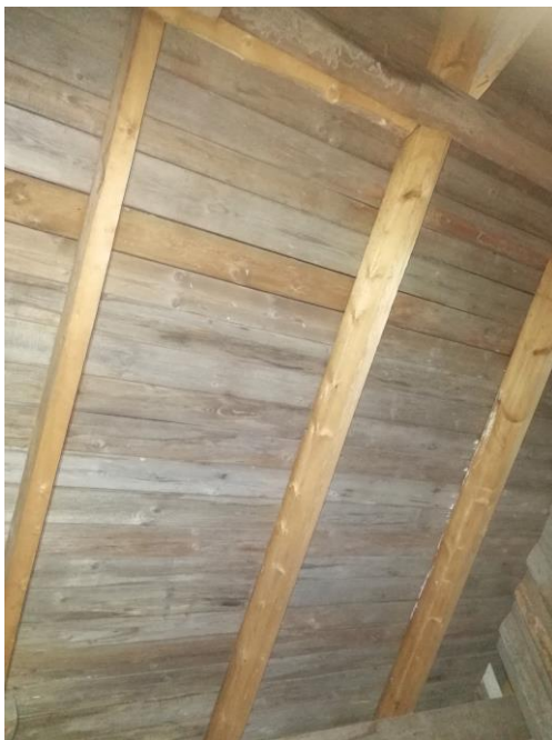
Kuva 28. Pohjoispään idänpuoleinen lape.
