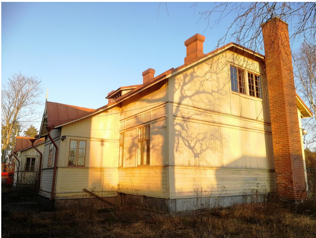
Kuva 2. Kohteen julkisivu länteen.
