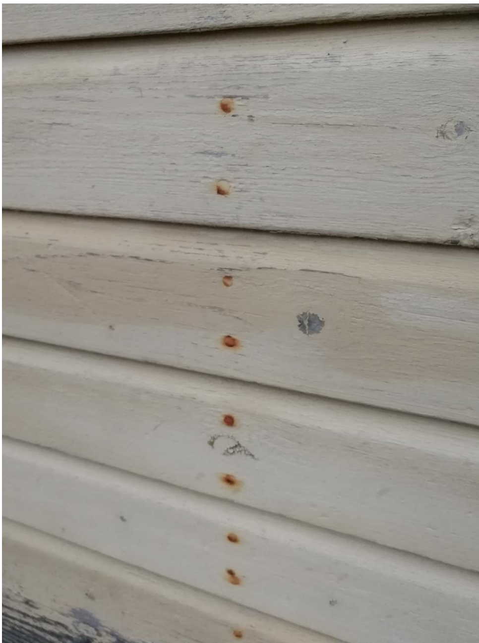
Kuva 14. Ulkoverhousnaulat.
