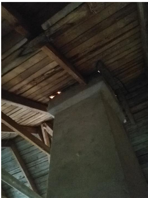
Kuva 29. Pohjoispään toinen läpivienti.
