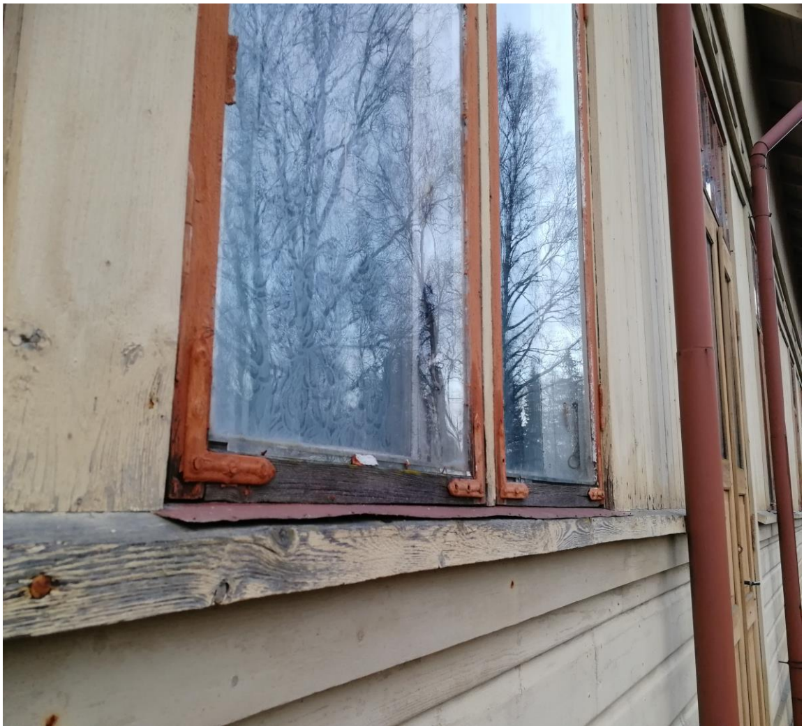
Kuva 34. Puutteelliset ikkunapellitykset.
