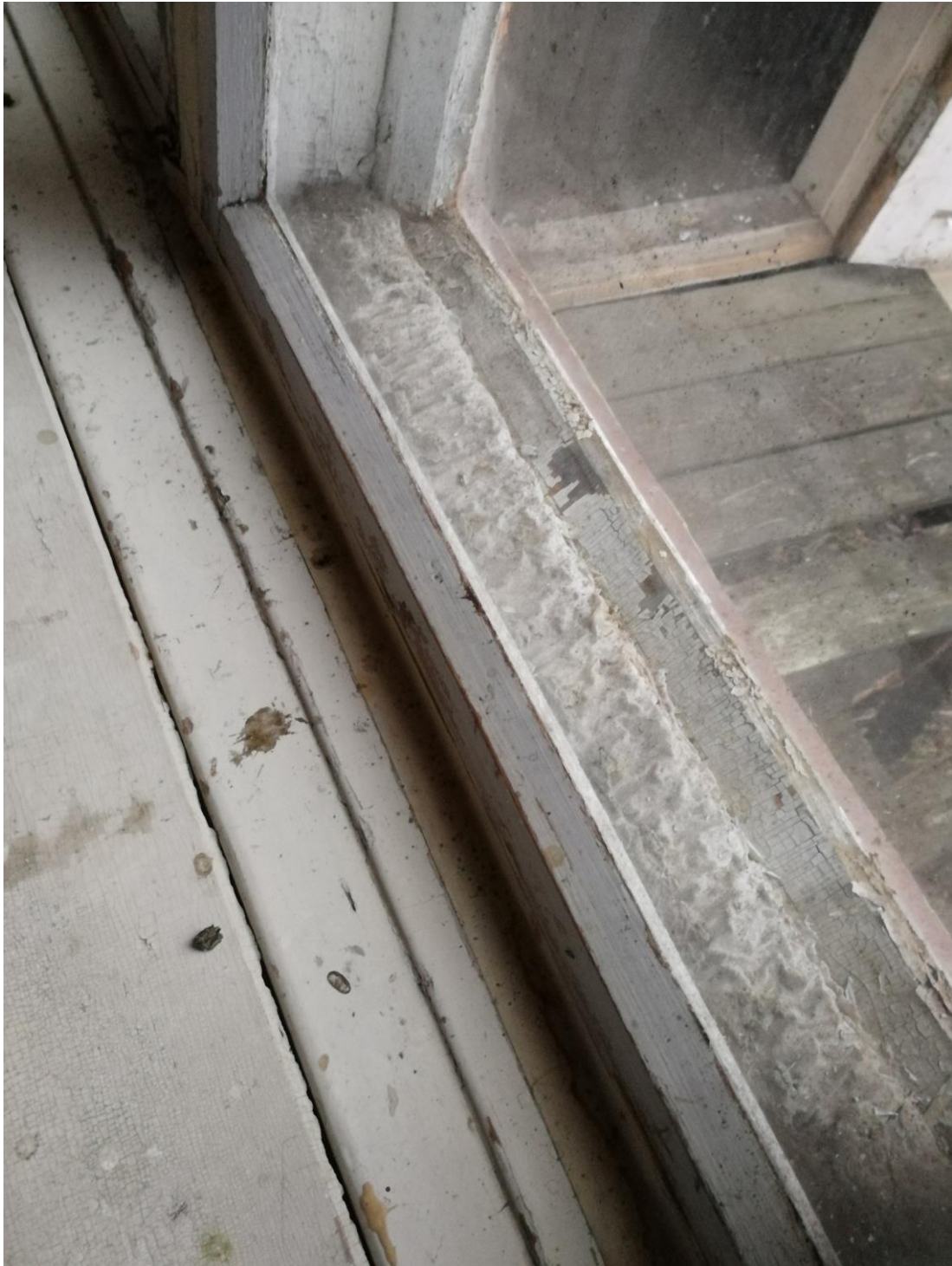
Kuva 33. Ikkunoiden pumpulitilke.
