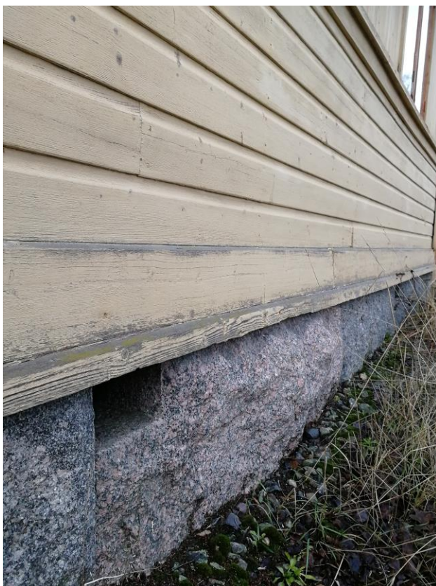
Kuva 18. Porakivestä valmistettu kivijalka.
