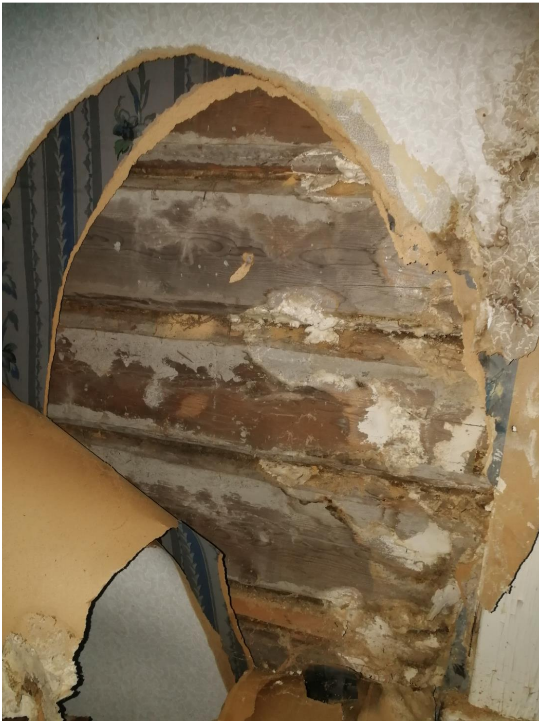
Kuva 15. Homevaurioitunut seinä.
