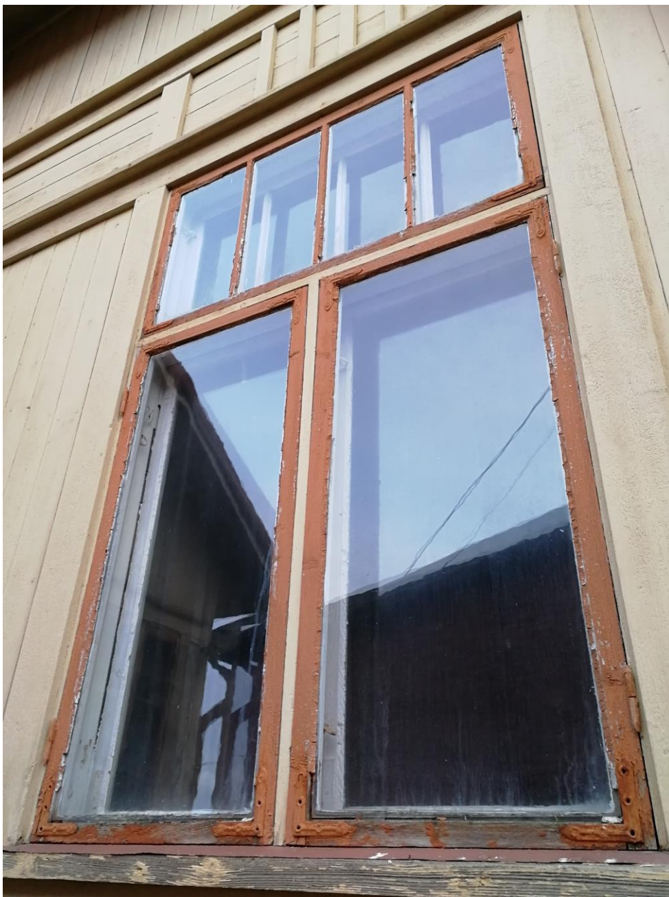
Kuva 32. Esimerkkikuva ikkunoiden ulkonäöstä ja kunnosta.
