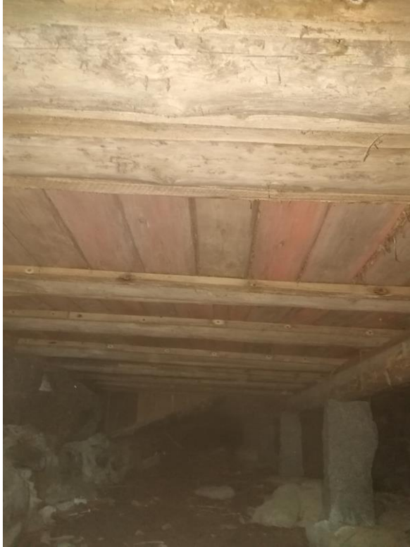
Kuva 5. Ryömintätila idän puolelta katsottuna.
