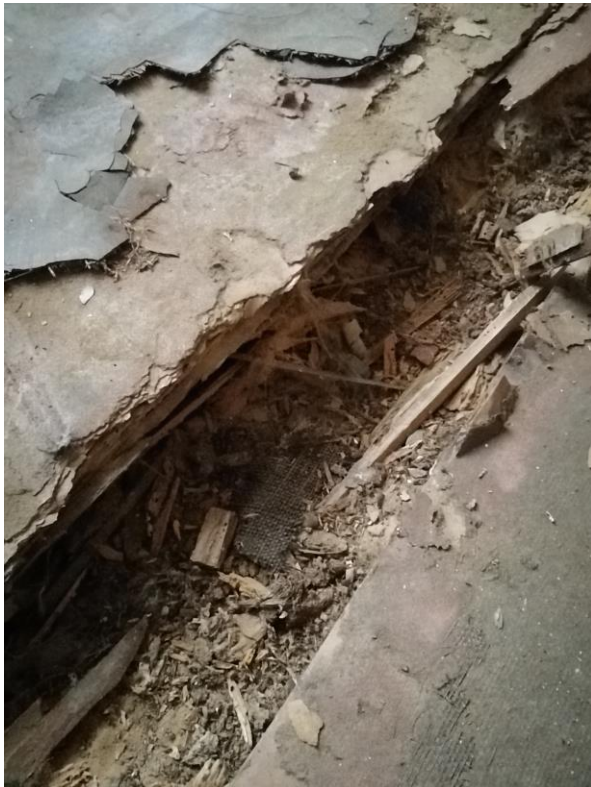
Kuva 9. Alapohjan pintamateriaali ja eristeet.
