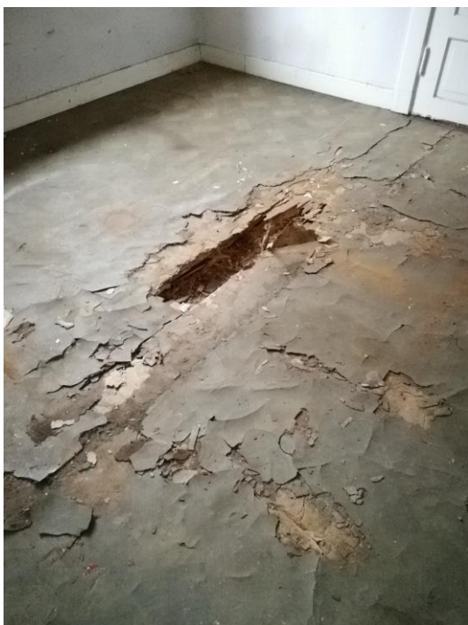
Kuva 7. Ryömintätilan maa-aines (hieta).
