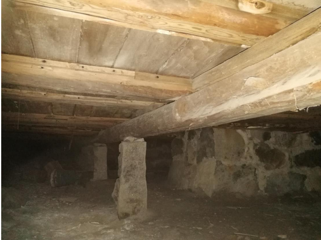
Kuva 4. Yleisilme ryömintätilasta lännen puolelta katsottuna.
