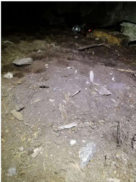
Kuva 7. Ryömintätilan maa-aines (hieta).
