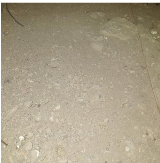
Kuva 24. Yläpohjassa ylin eristekerros on maa-ainesta, jonka tehtävänä on ollut toimia palopermantona.
