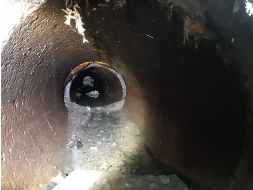
Kuva 2. Vaihdeettava rumpu työmaalla
