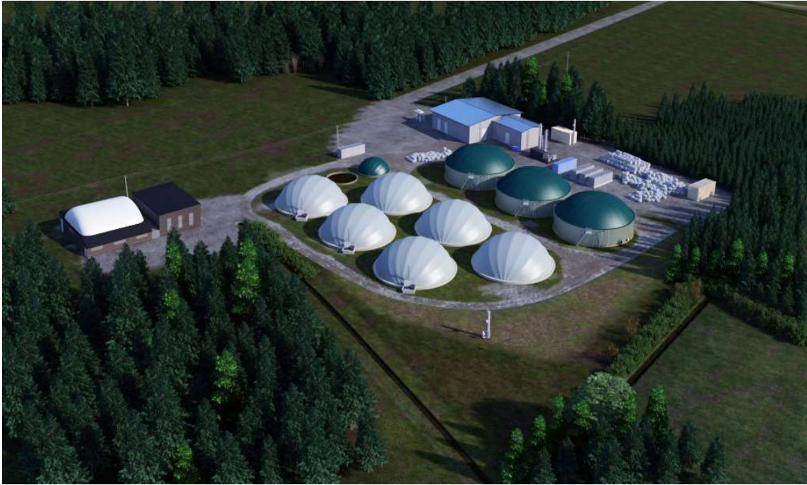
Figur 2. Jeppo Biogas anläggning i Jeppo. /1/
