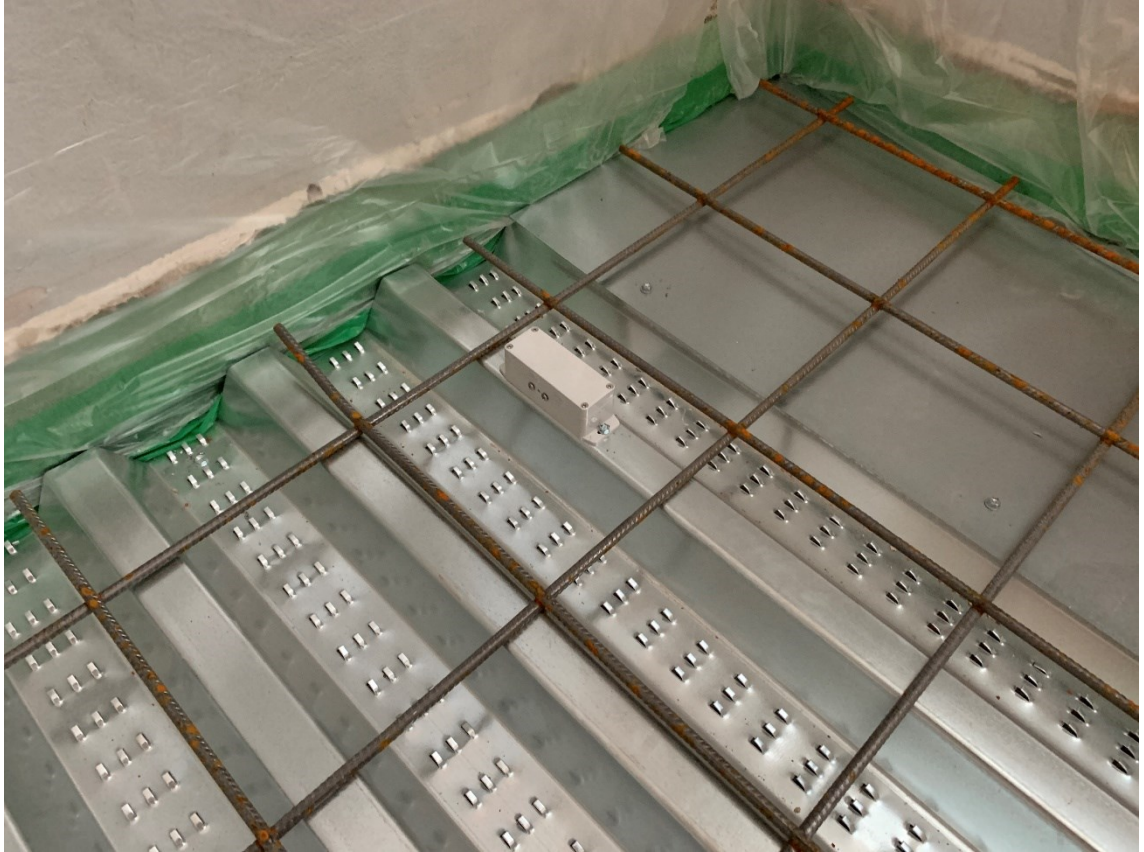
Kuva 13. Etäluettava anturi asennettuna. Anturin kyljessä näkyvillä mittauspääät.
