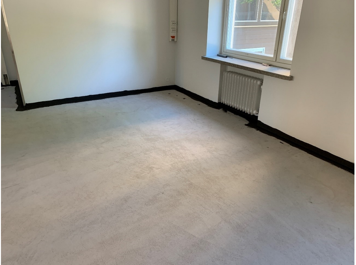
Kuva 12. Pintalattiat valettu ja Ardex 8+9 -eristemassalla tehdyt tiivistystyöt tehty.
