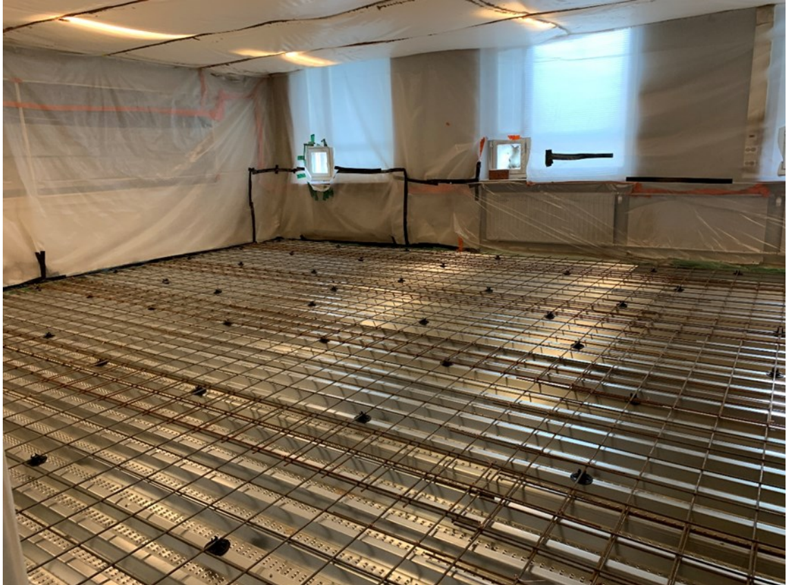
Kuva 11. Liittolaattalevyt asennettu ja raudoitukset tehty.
