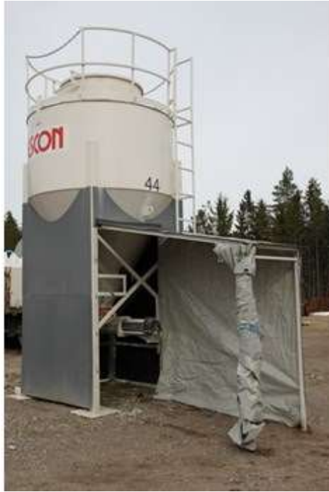
Kuva 11. Lattiatasoitteen pumppaukseen käytettävä siilo.
