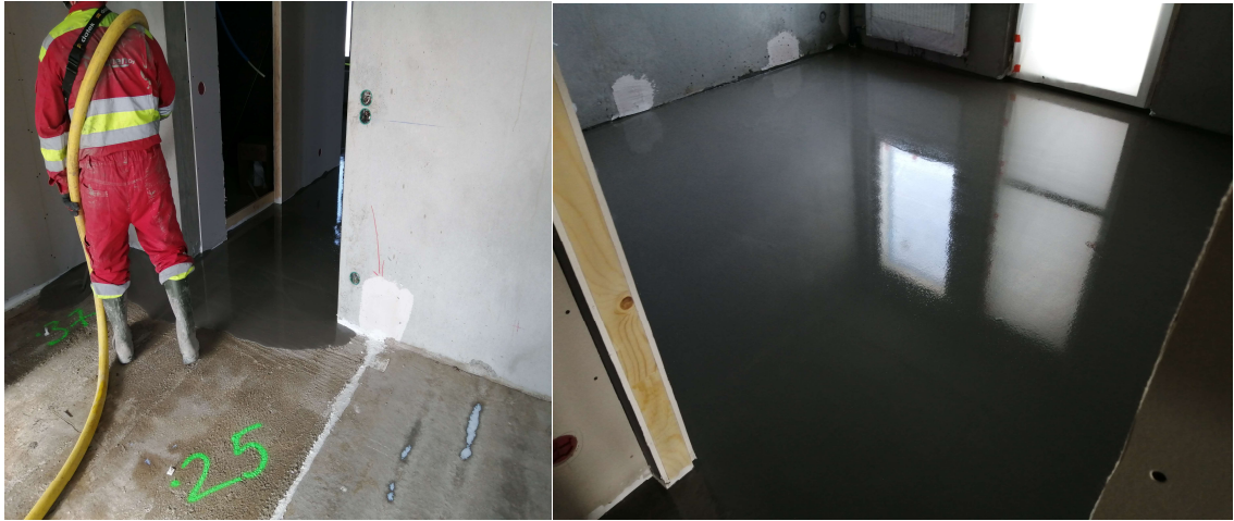
Kuva 9. (Vas.) Lattiatasoitteen pumppaaminen.
