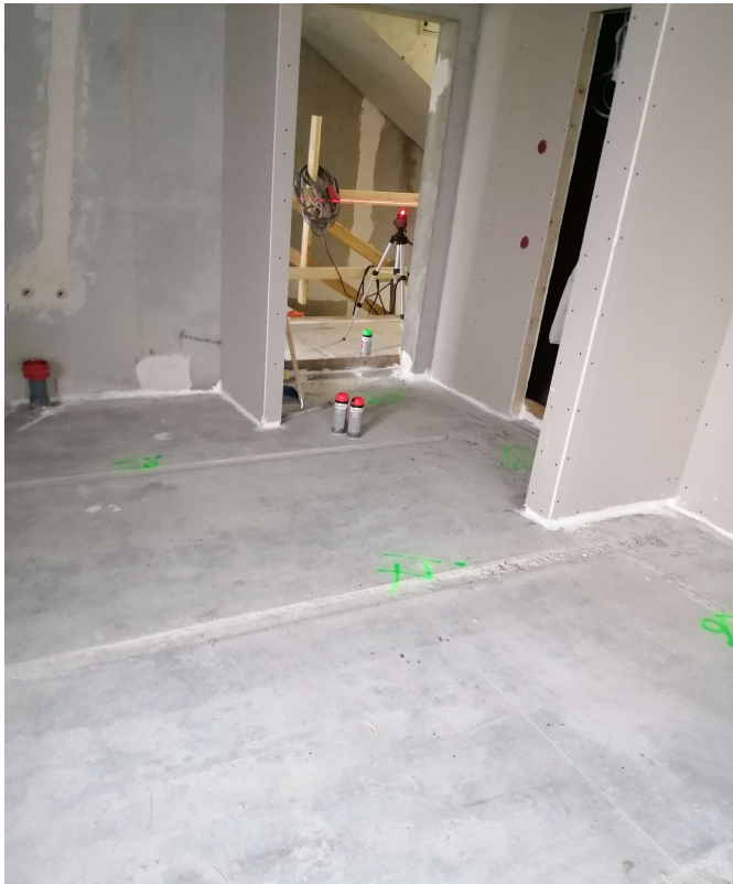
Kuva 7. Ontelolaatastoon merkattuja korkoja. Korkeiden merkkaukseen käytetään apuna laseria.
