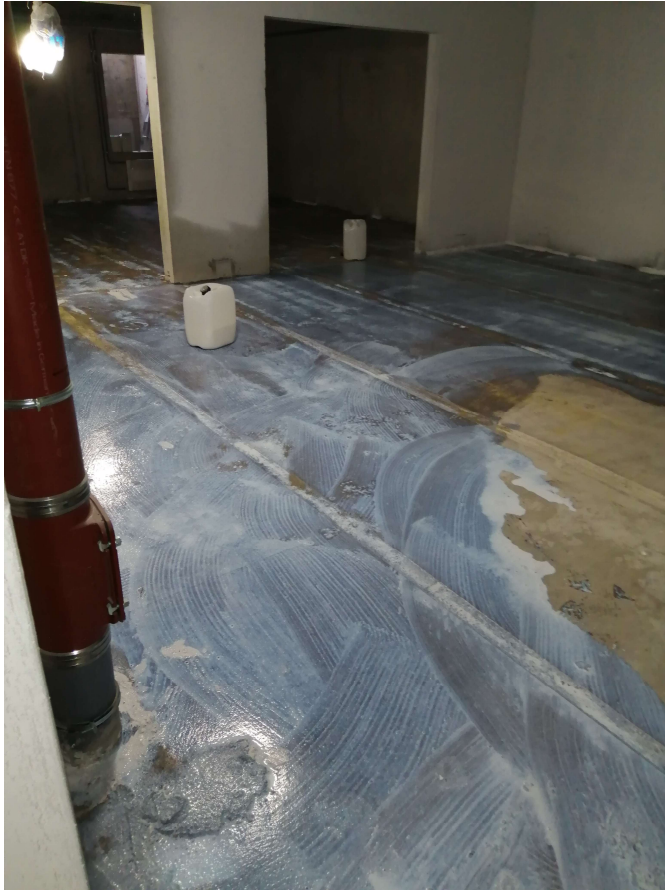
Kuva 6. Kuvassa pohjusteen levitys käynnissä. Työmaalla pohjustusta kutsutaan primeroinniksi.
