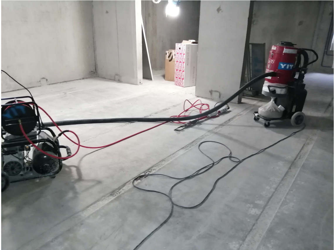
Kuva 3. Kuvassa suoritetaan etuputsia, paineilmapetkeleellä ja imurilla. Paineilmapetkele on punaisen letkun päässä oleva laite.
