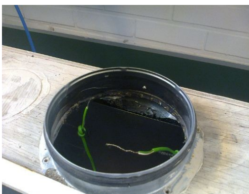
Kuvat 5 ja 6. Vasemmassa kuvassa ilmanpoistoaukko korjaamatta ja oikeassa ilmanpoistoaukko korjattu. Kuvissa näkyvät ilmanpoistoaukon lämpömittauspisteet. Kuvat Heikki Raunio.
