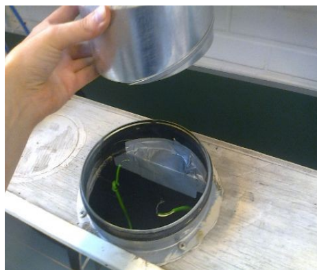
Kuvat 5 ja 6. Vasemmassa kuvassa ilmanpoistoaukko korjaamatta ja oikeassa ilmanpoistoaukko korjattu. Kuvissa näkyvät ilmanpoistoaukon lämpömittauspisteet. Kuvat Heikki Raunio.
