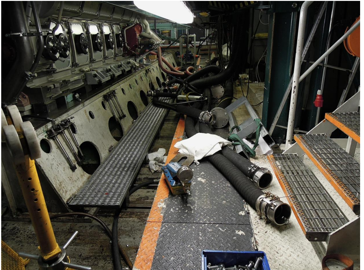
Kuva 7. Koeajon aikaiset putkiliitokset.
