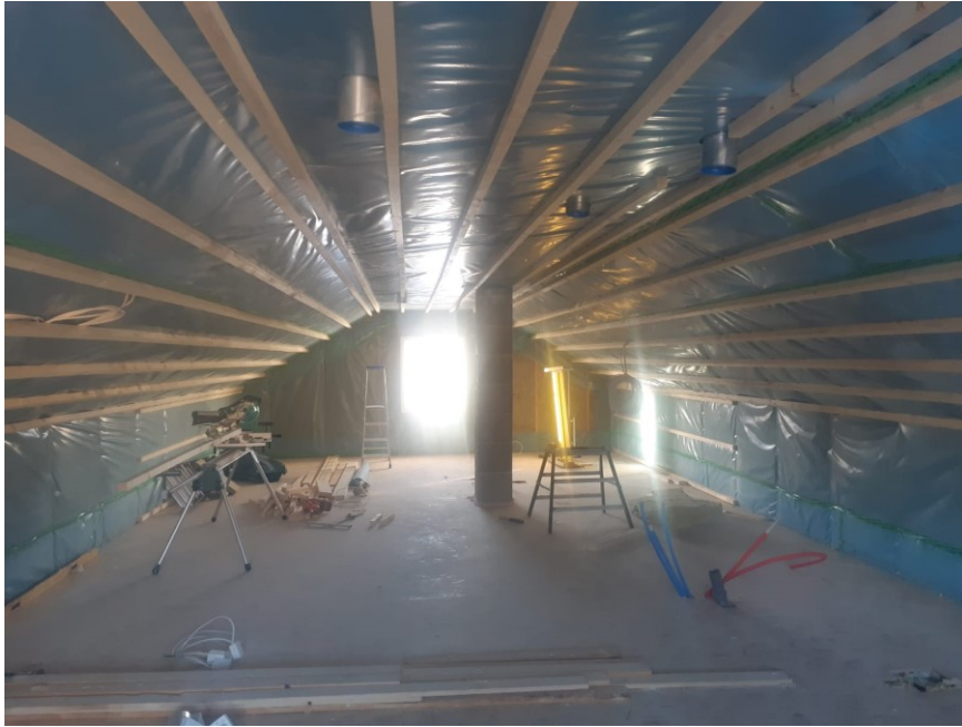
Kuva 10. LVI- ja sähköasennuksia sekä höyrynsulkumuovi
