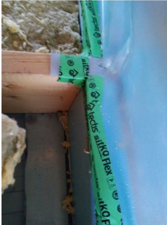
Kuva 9. Työmaakuva höyrynsulun liitoksesta alapohjaan
