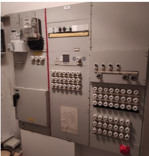
KUVA 10. Esimerkkikohteen sähköpääkeskus
